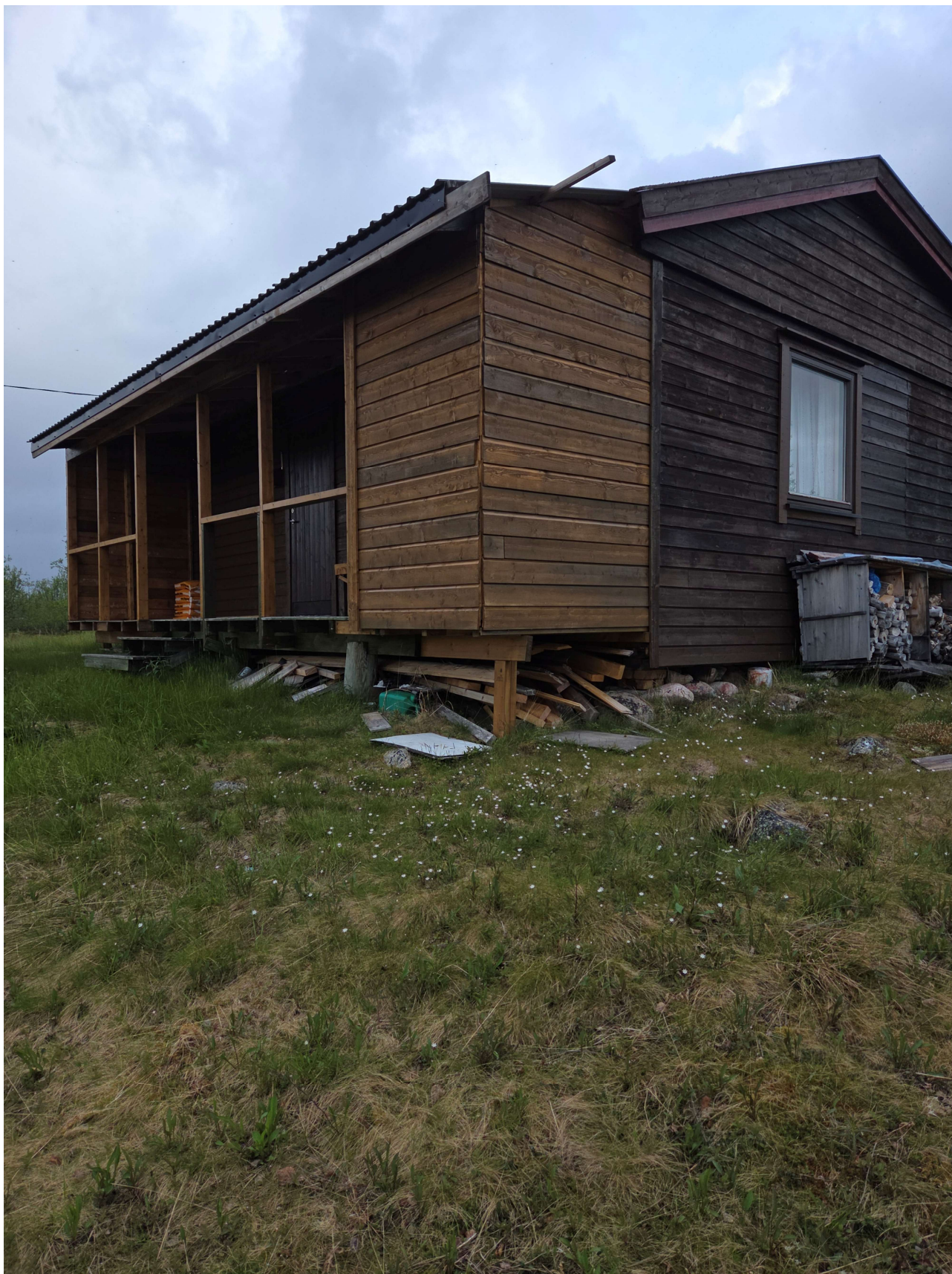
Figur 9: Bilde tatt 02.07.25, mot sørøst og viser hyttens front og inngangsparti. På bildet kan man se takoverbygget som er satt opp over inngangspartiet. På kortsiden av tilbygget og en del av frontpartiet, er det satt opp en vegg av liggende trepanel. Panelet på takoverbygget har avvikende farge i forhold til hytten, og fremstod som nybeiset.
