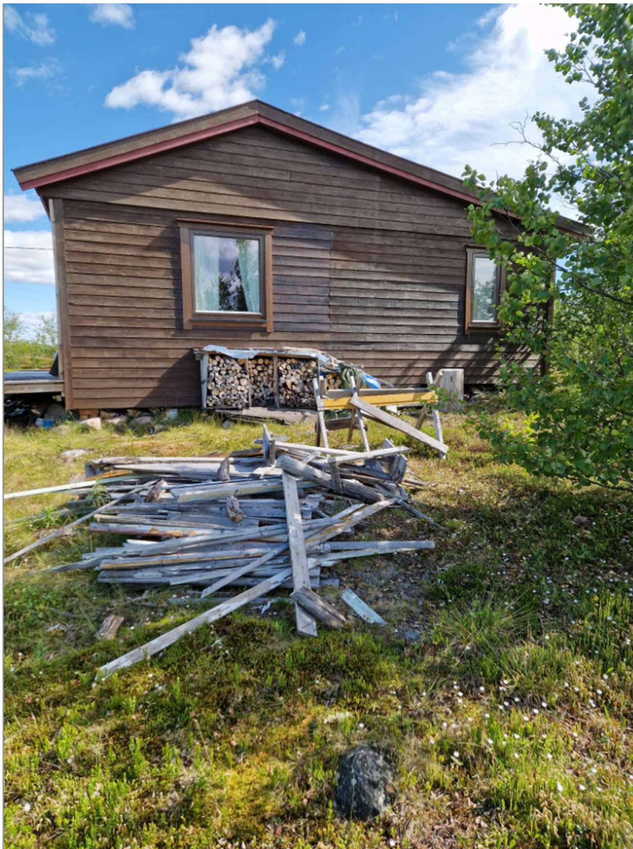
Figur 7: Bildet er tatt 23.06.24, mot øst og er hentet fra Naturoppdrag. Bildet viser høyre side av hytten. I venstre billedkant kan platten som ligger utenfor inngangspartiet.
