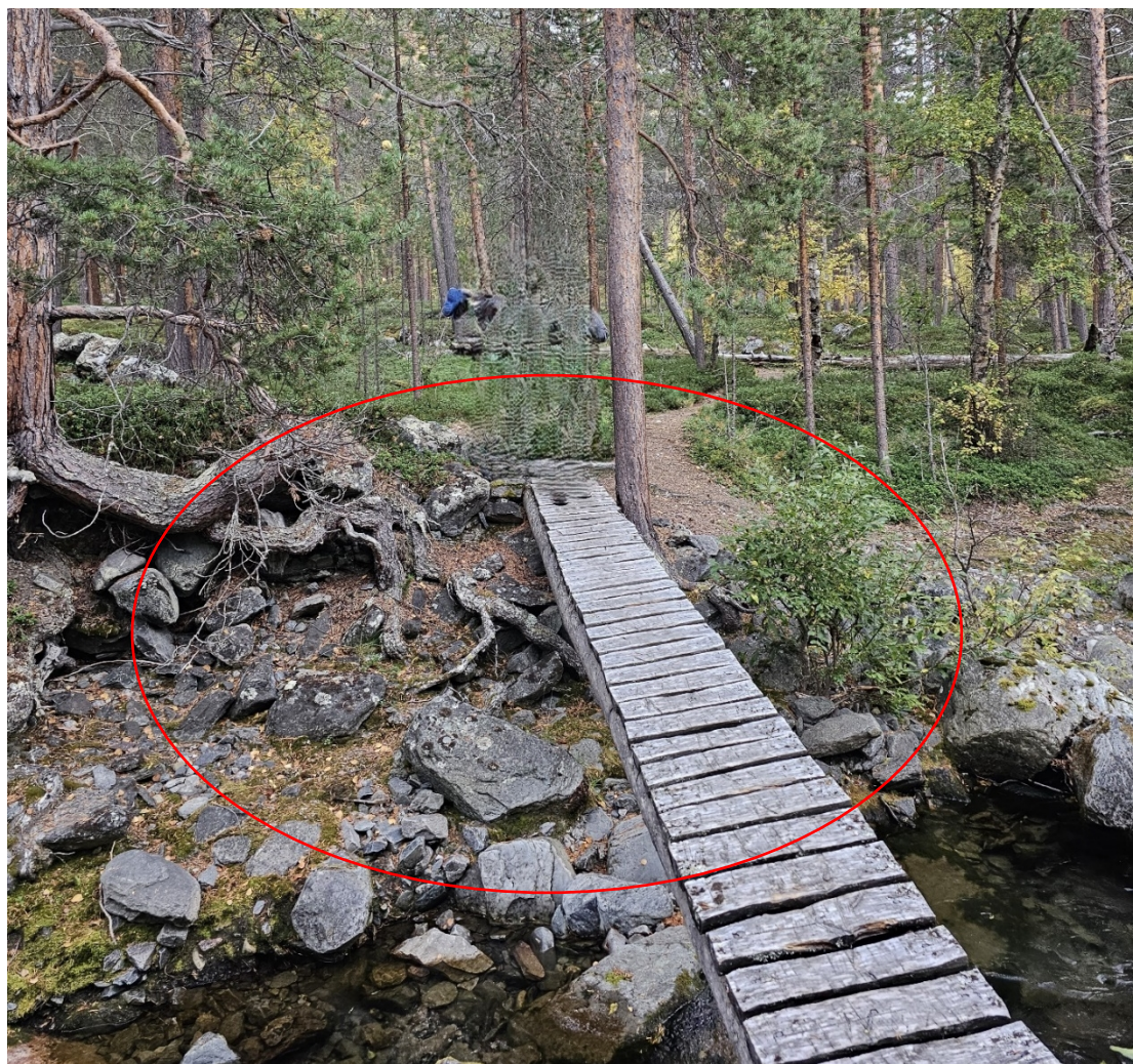
Figur 4: Rød ring viser elvas utgraving under brukaret
