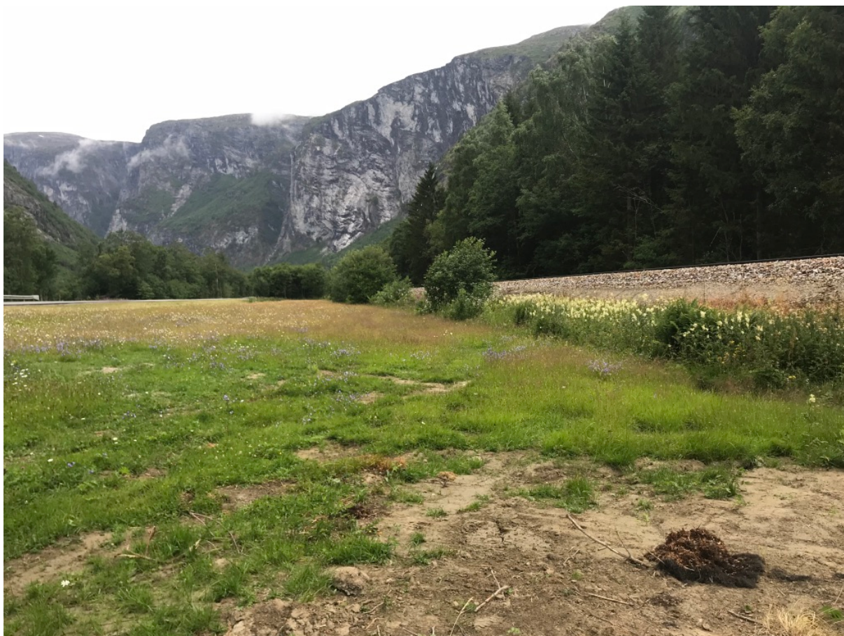
Figur 2. I forbindelse med graving av en kabel våren 2018 ble det gjort skadelige inngrep i den søndre delen av slåtte- marka på østsida av vegen. Her vil det bli foretatt opprydding og naturlig revegetering. Foto: Bjørn Harald Larsen.
