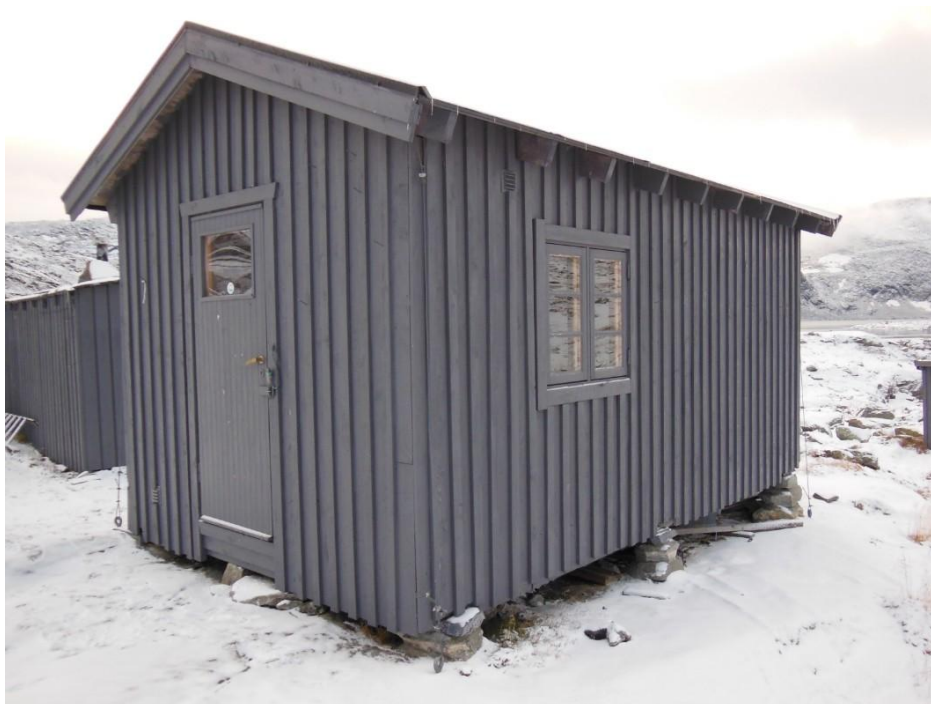
Bilete 2: Areal 15,4 m 2 Lengde 5,05 m Bredde 3,05 m Grytten fjellstyre har en halvdel av huset med to senger, gasstopp og gassovn. Rauma energi bruker den andre halvdelen til lager. Foto og informasjon frå SNO (Naturopdrag.no)
