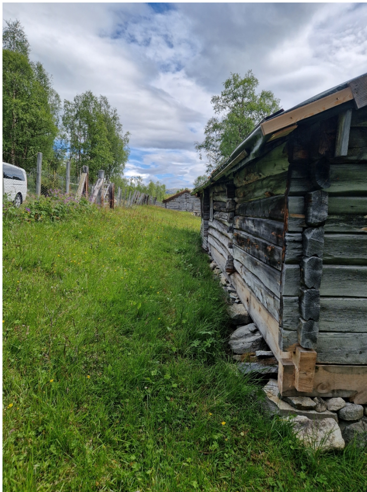
Seterhuset si langside mot vegen
