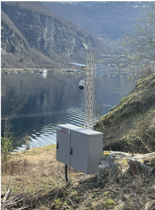
Figur 2: Masta på biletet er av typen gittermast frå Lattix og er 4 meter høg. Masta står ved MRFK sitt skredvarslingsanlegg ved Fv. 63 i Geiranger.
