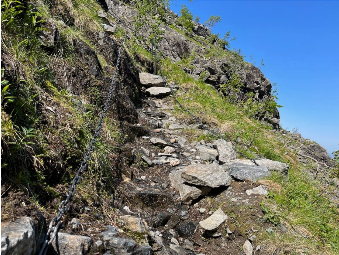
Figur 15 Ved strekningspunkt 33 er det lokalt ustabil mark i bratt skråning. Bildet viser tydelig slitasje og fare for erosjon. Her kan enkelte trappetrinn være en fordel.
