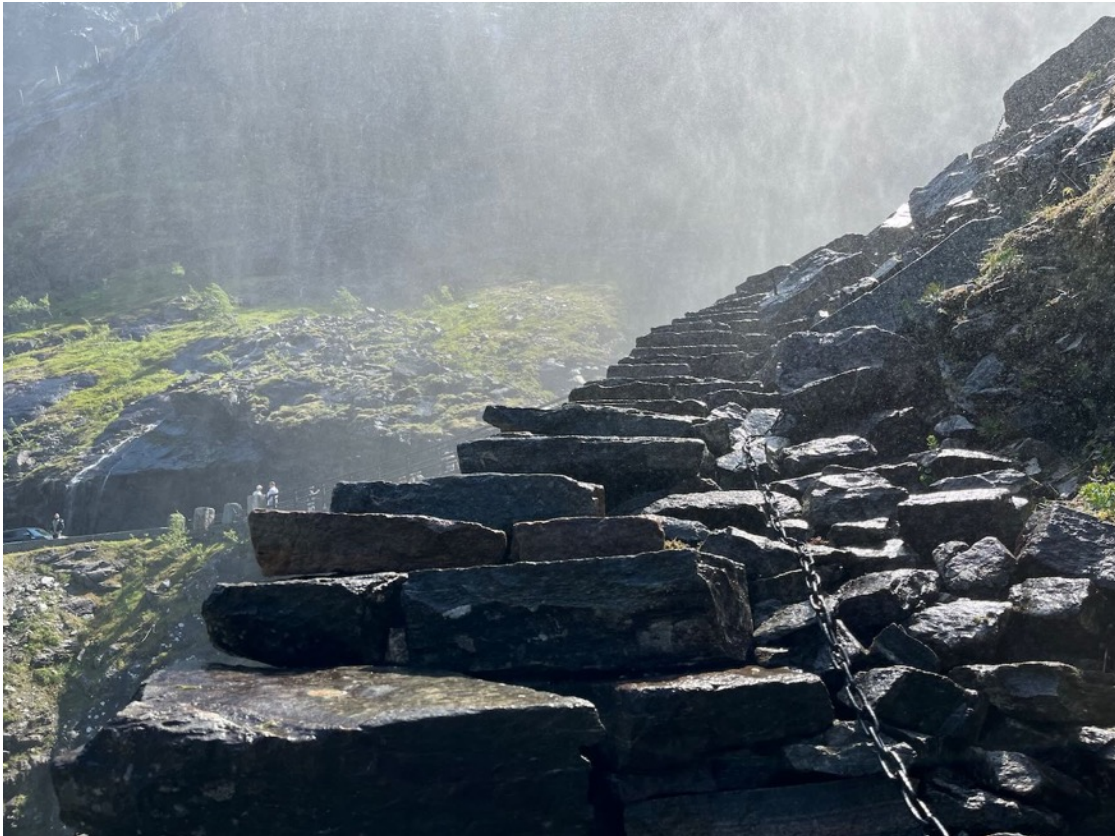
Figur 16 En nokså omfattende sherpatrapp i fossrøykpreget stiavsnitt ved strekningspunkt 35. Trappa gir økt sikkerhet og beskytter vegetasjonen i bratt skråning med ustabil mark.
