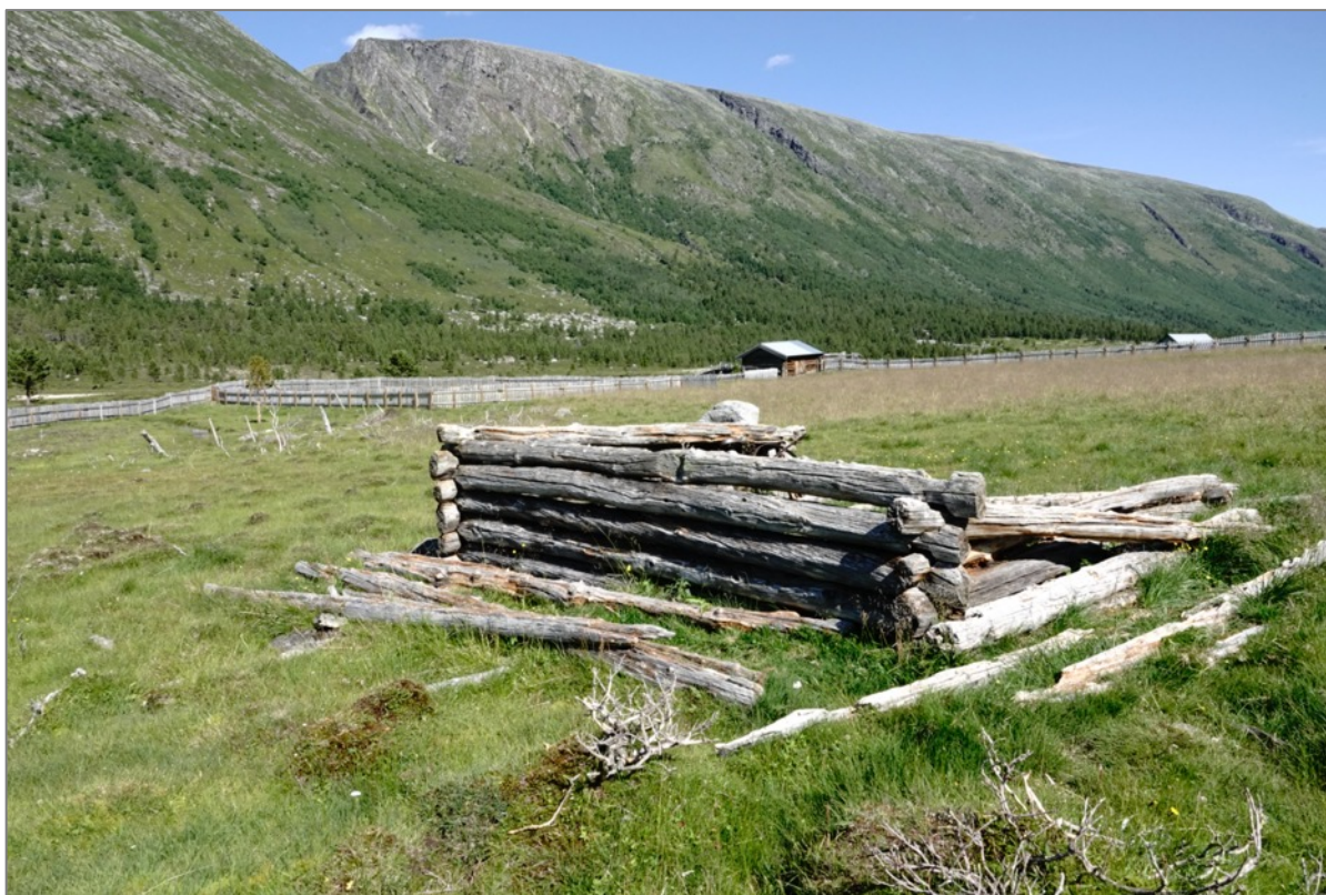
Figur 14. Nedrast løe på Sterringen med forekomst av furusotbeger. Ved restaurering eller gjenoppføring av bygninger vil gjenbruk av materialer være viktig (også av kulturhistoriske hensyn). Generelt bør det foretas minst mulig utskifting, og ubehandlet treverk bør ikke erstattes av malte eller beisete flater. Eksempelvis vil det ved en gjenoppføring av denne låa være fullt mulig å gjenbruke flere laftestokker. Foto: Geir Høitomt, 10.8.2020.
