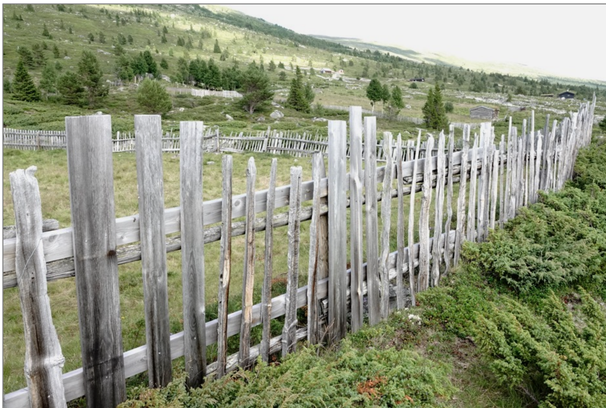
Figur 15. Vedlikehold av dette gjerdet på Breidstulen er utført som en kombinasjon av nye materialer og gjenbruk av gammelt. Her vokser både vanlig sotbeger og furusotbeger rikelig på de gamle materialene. De nye materialene er ubehandlet treverk og vil være aktuelle vokseplasser på sikt. Foto: Geir Høitomt, 10.8.2020.
