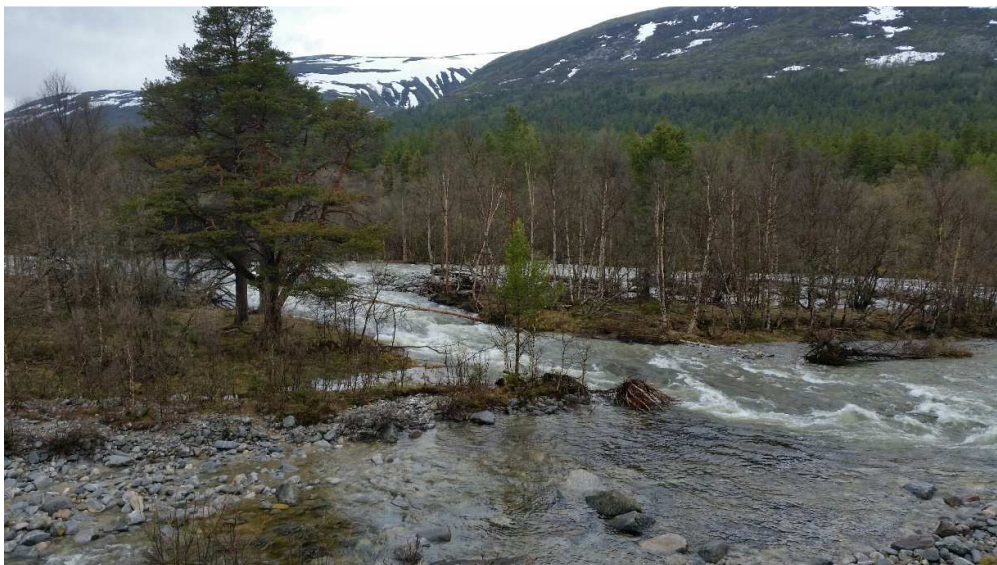
Bilete frå befarung 5.juni 2020. Ved halvstor vassføring går veldig mykje vatn over i sideløpet mot vegen.
