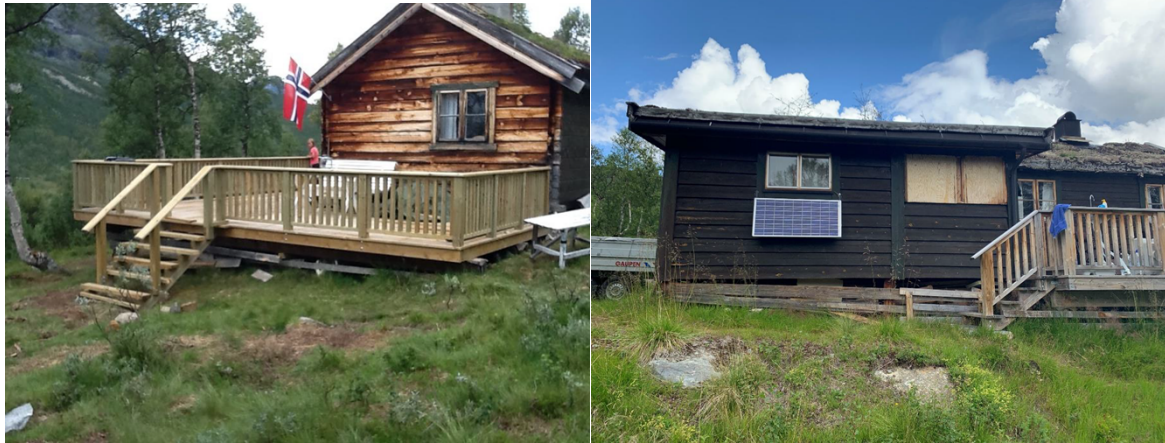
Foto t.h viser fasade frå sør-aust, av tømmerdelen og plattning/terrasse bygd i 2013/2014. Foto t.h viser fasade frå aust. Her er plan og endre til saltak vinkelrett på hovedhytta.
