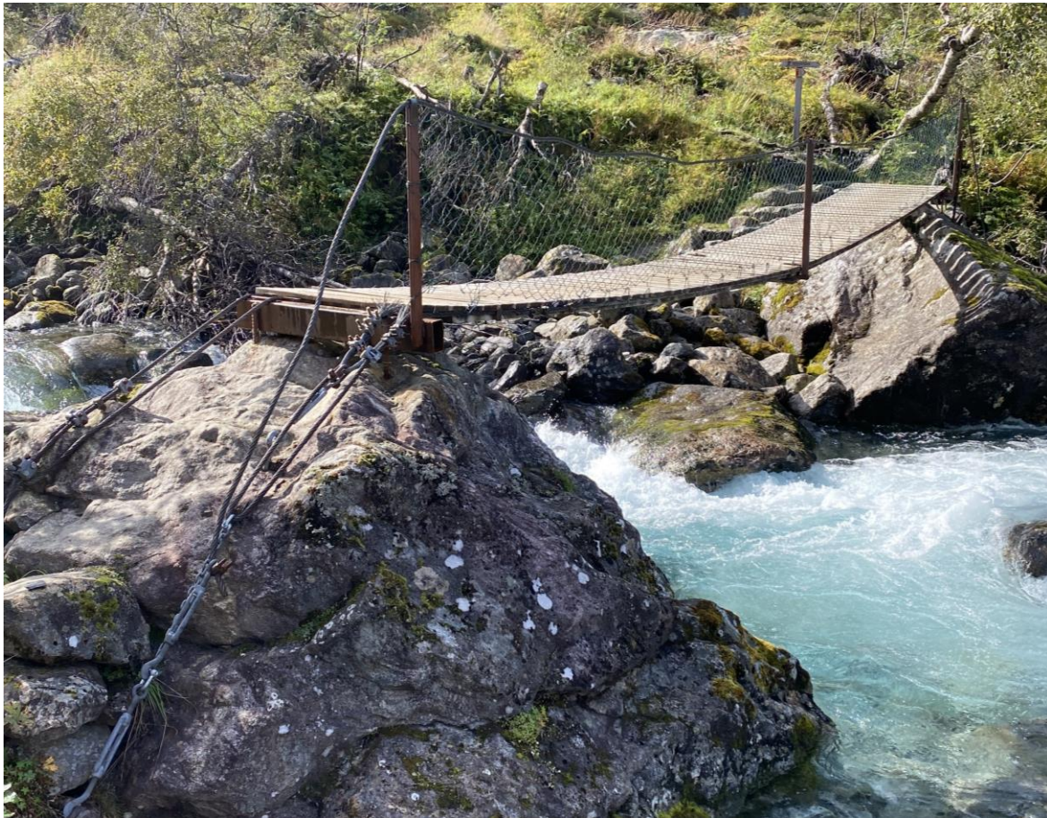
Figur 24: Nærbilde av brua innerst i bunnen av Isterdalen som er fundamentert i en stor steinblokk på hver side av elva.
