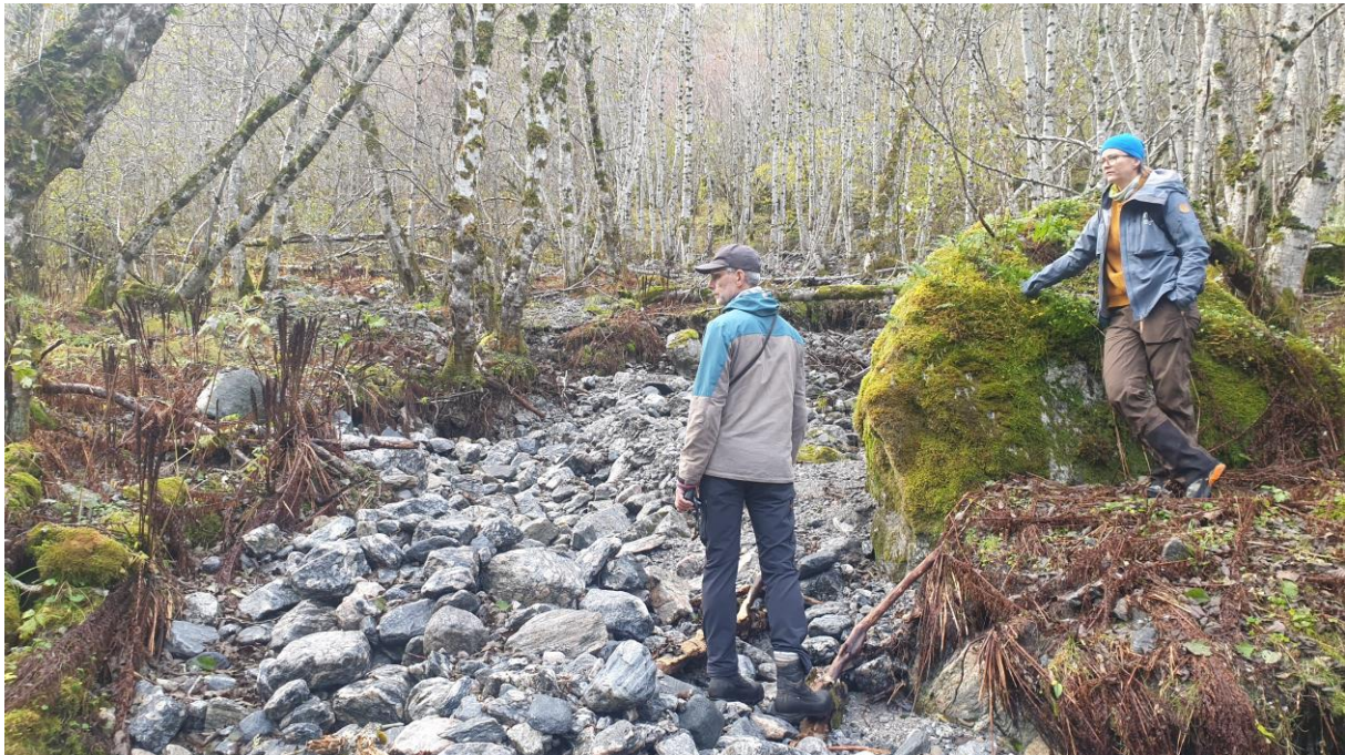
Figur 23: Stein 20-30 meter oppstrøms som kan benyttes som fundament for ny klopp.
