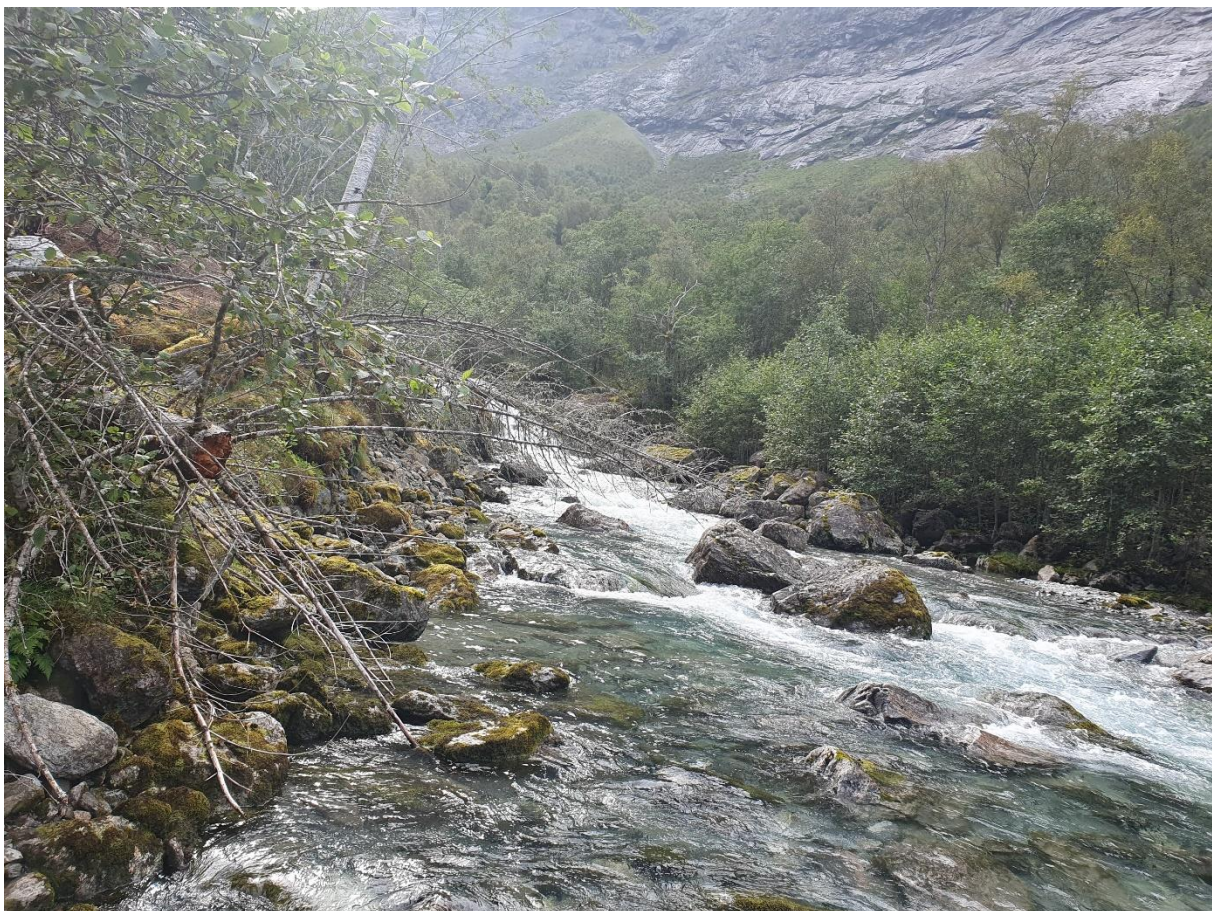
Figur 14: Erosjonsutsatt skråning oppstrøms aktuell plassering B.
