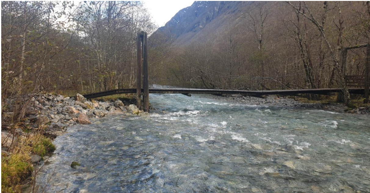
Figur 21: Brua 200 meter fra plassering A.
