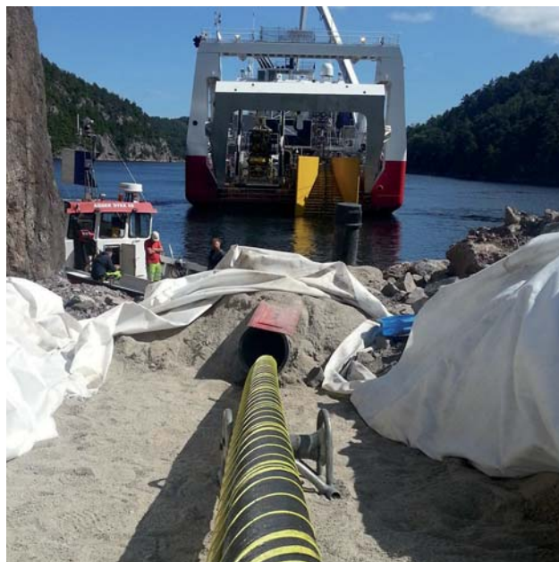
SJØKABEL: Strekking av sjøkabel. Illustrasjonsfoto: Agder Dykk
