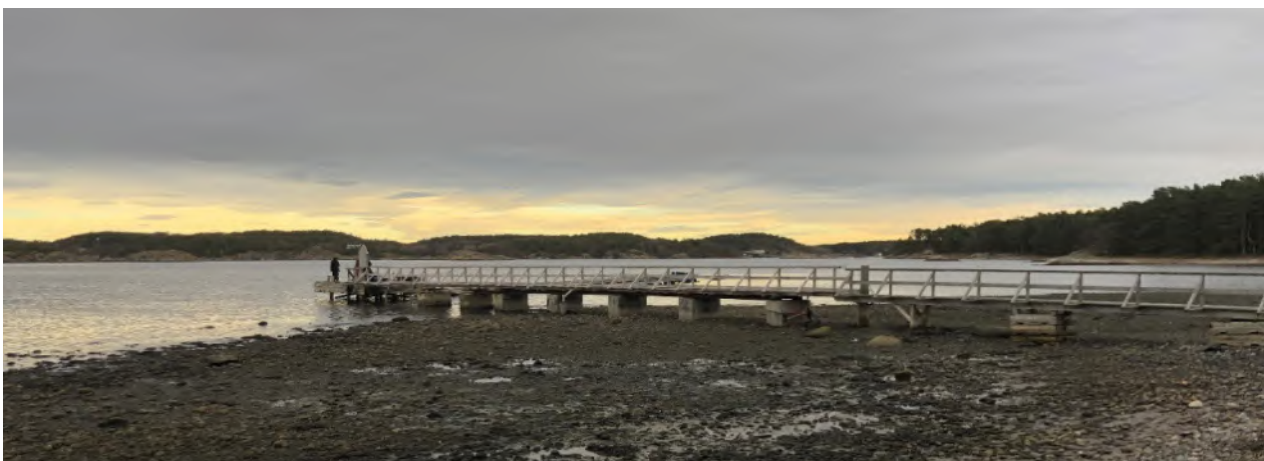
Bryggeanlegget er svært synlig i det åpne landskapsrommet
