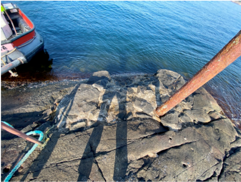
Bilde 1. Eksisterende brygga.
