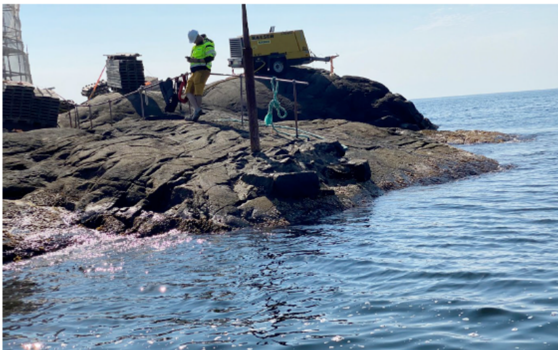
Bilde 3. Eksisterende brygga mot nord
