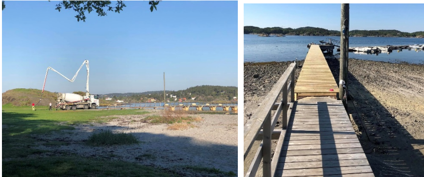
Bilder fra 2018 som viser en stor betongbil ved brygga og atkomstbrygga med nytt treverk.
