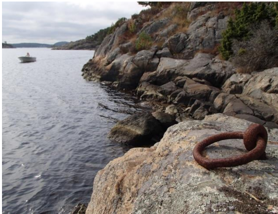
Foto 13 Reg Nr 357 Lille Bryllupsholmen. Ring innsatt ved det vestre av utløpet Nidelva, Nativigstrømmen. Dette finnes flere slik oppetter elveløpet og de har trolig vært brukt til varping, i dette tilfellet for å dra skuter opp mot strømmen. Foto: Ø.Rosvinge
