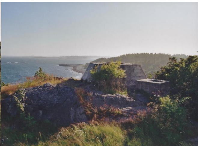
Foto 22 Fundamenter til radaranlegg på Såta, Hove Foto: Erling Vatne
