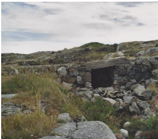
Foto 23 Brekka, bro bygd av tyske krigsfanger. Foto: Erling Vatne
