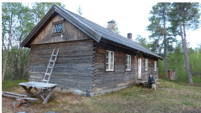
Figur 13. Gjøkvannshytta som er aktuell som nytt hovedbygg på Gjøkhotellet
