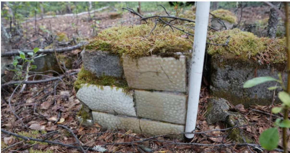
Figur 34 Brakketuft 10845. Glaserte fliser på rester av ovn- og skorsteinskonstruksjon.
