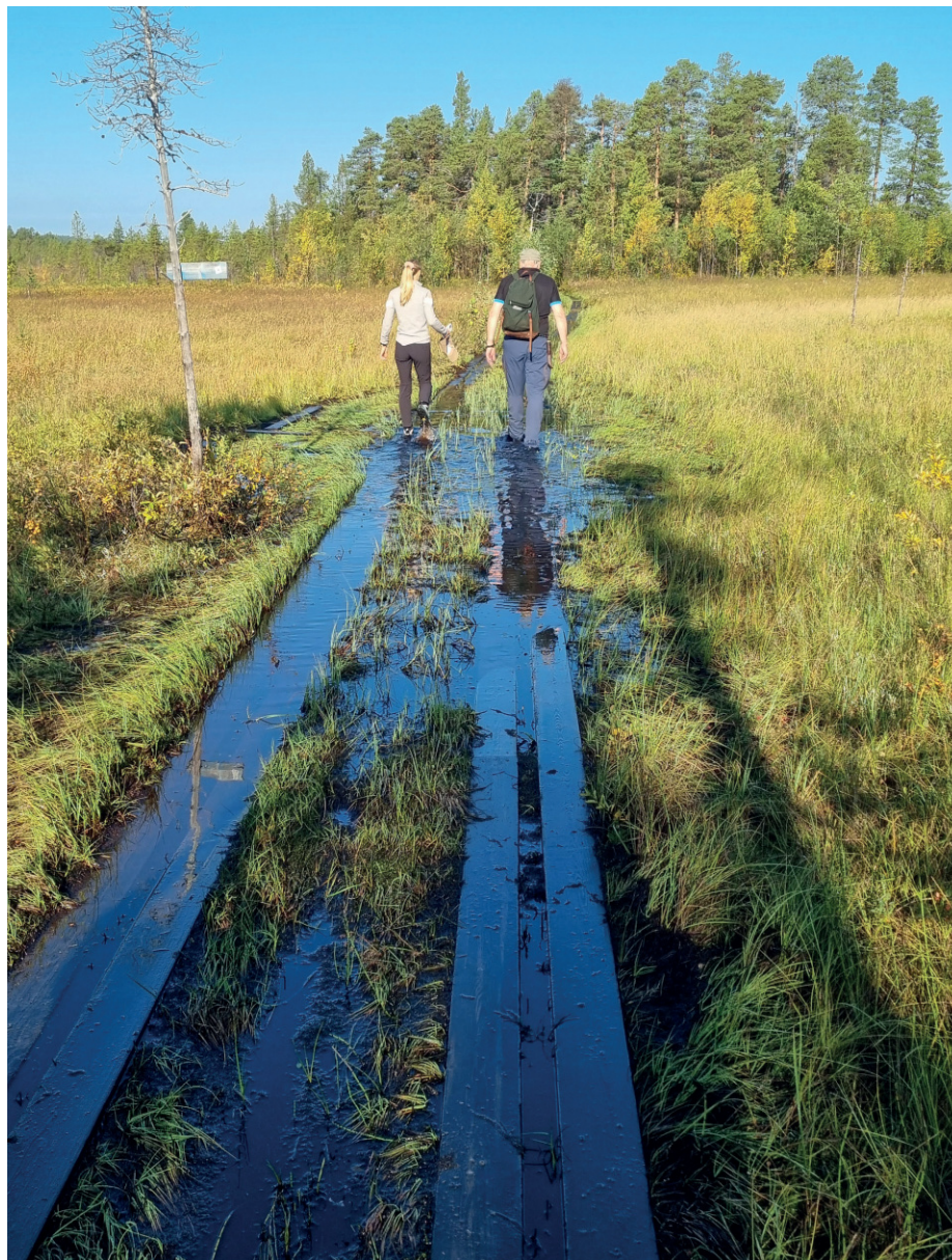
På deler av strekningen ligger kloppen under vann. Dette bør utbedres, slik at man kan gå mer tørrskodd.
