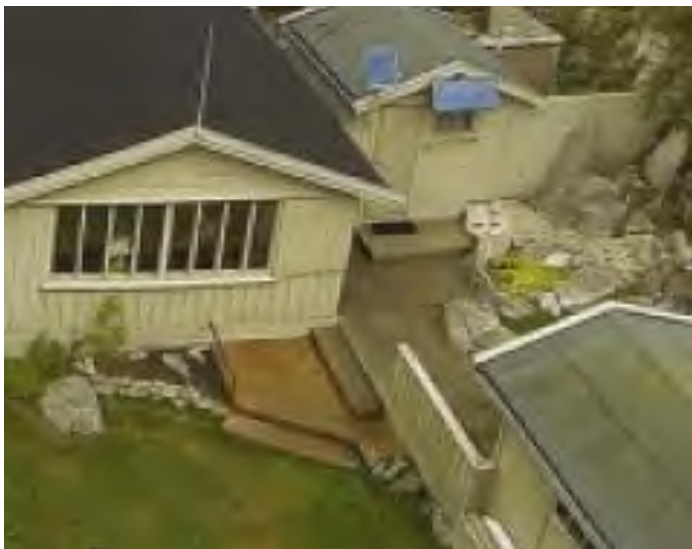
Bilde 2 - viser terrasser bygget på 80 tallet.
