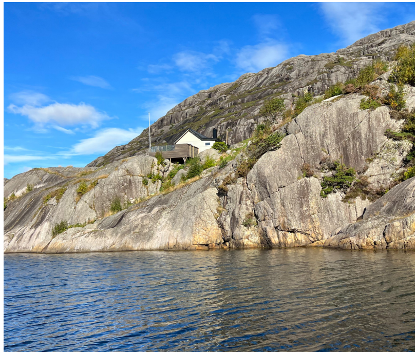
Figur 5 Bilde av sørsiden til fritidsboligen tatt fra sør.
