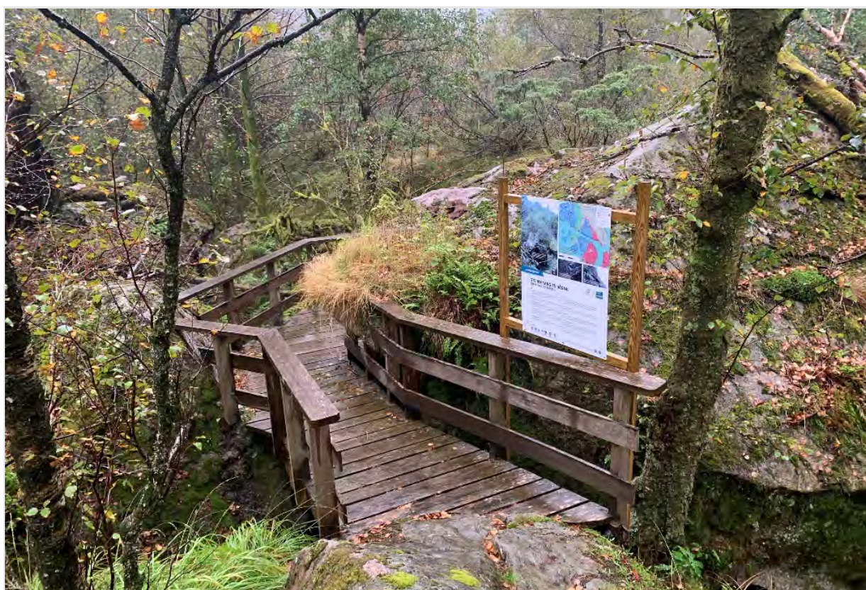
Figur 9 Ny plankesti rundt rasområdet på turstien mellom Dåstøl og Stø. Foto: Rambøll.
