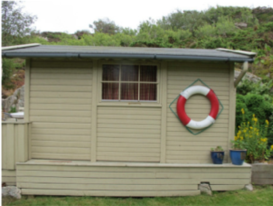
Tidligere anneks (bygd en gang i tidsrommet mellom 1975-80tallet)
