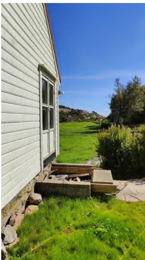
Tiltak nr. 4 – Ny trappeløsning (bilder viser situasjon etter fjerning av terrasse, inkl. eldre fundament som ønskes benyttet for ny trapp-/repoløsning)
