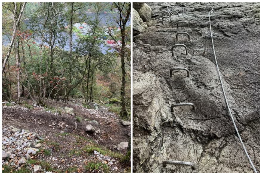
Figur 4 Sti fra Roligheten mot Brufjell går i bratt terreng på ustabilt substrat (til venstre). Nedstigning til Brufjellhålene går på Via ferrata med jernsteg boltet i fjellet og med stålwire som sikring (til høyre). Foto: Rambøll.
