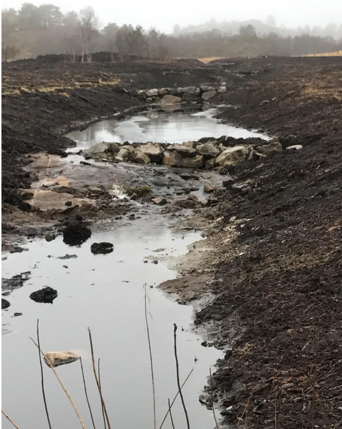
Figur 6. Åpne vannspeil med terskler og brede kantsoner er etablert i Nord-sør kanalen der det tidligere var en helt gjengrodd landbrukskanal i tett kratt.
