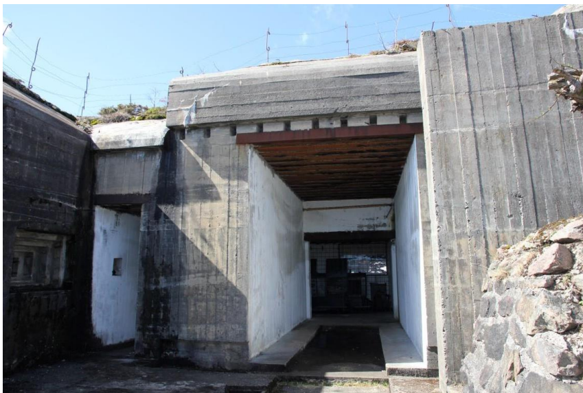
Figur 14. Inngangspartiet til bunkergarasjen for lyskaster. De opprinnelige skyvedørene i betong ble aldri installert.
