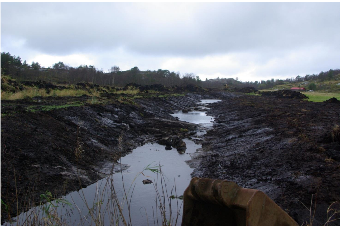
Figur 4. Mønstremyr gjenåpnet grøft med slake kanter oktober 2016. Foto BV.
