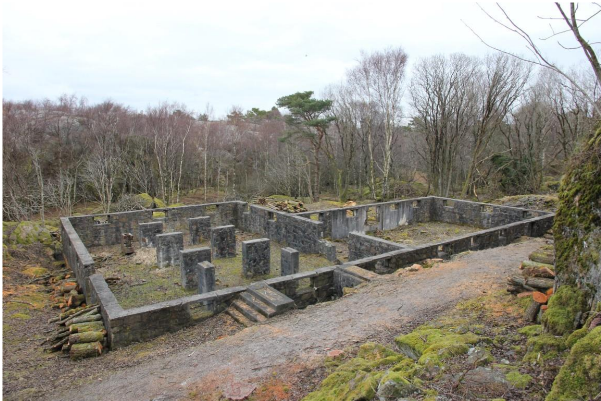
Samme grunnmur etter treskjøtsel.
