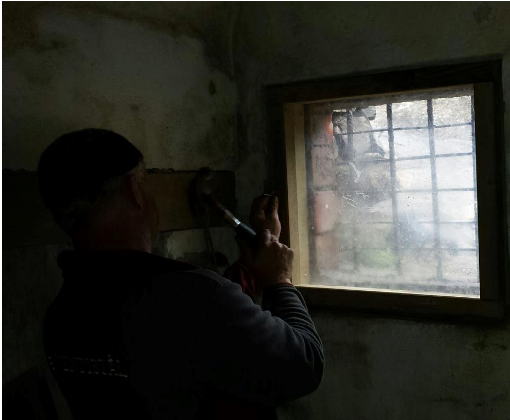
Fra innsiden av bunkeren under utskiftingen.
