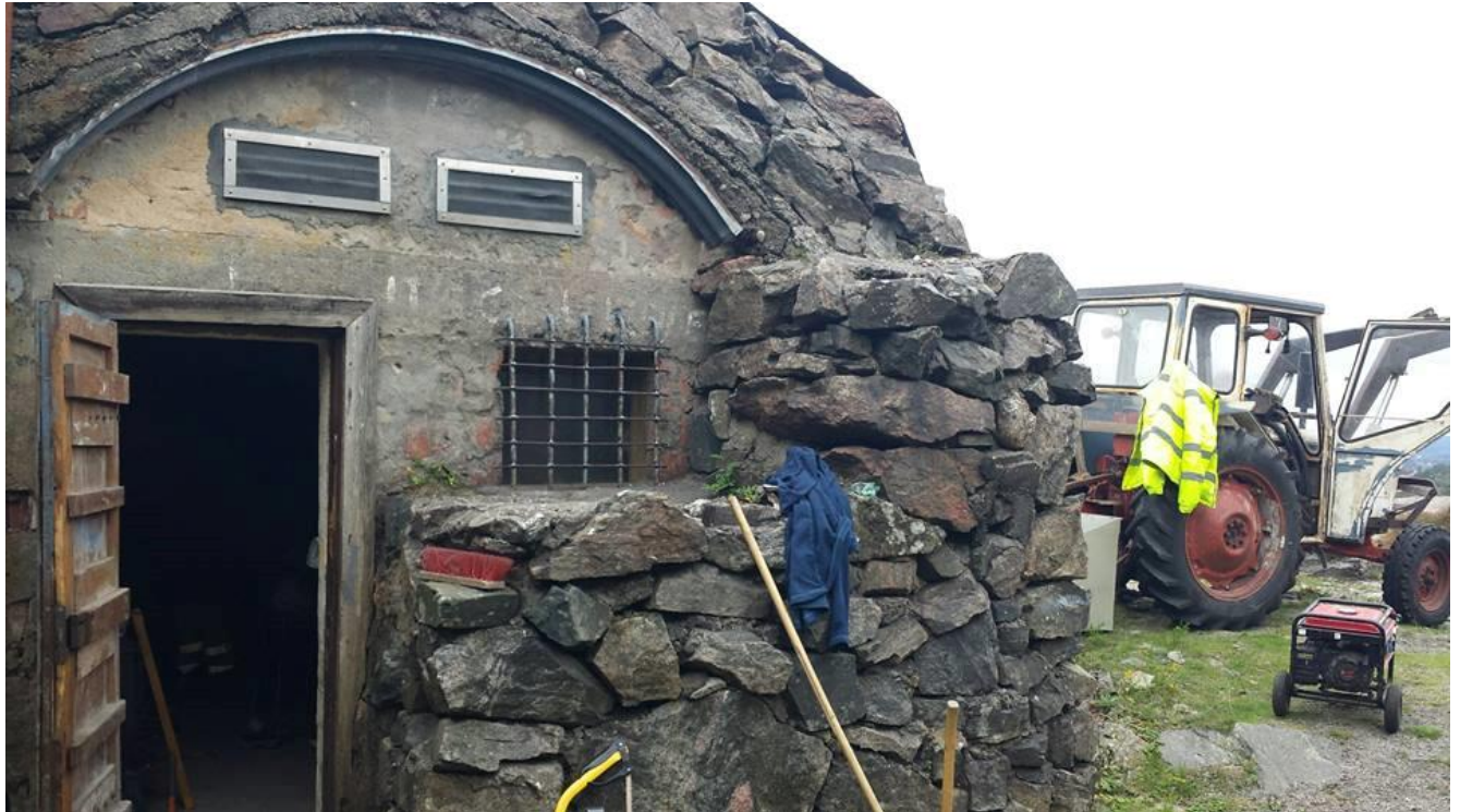
Vinduet med den forsterkede gitterrammen.
