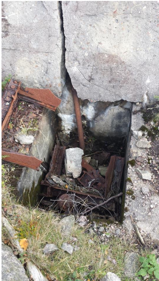
Sjakten før gjenfylling.
