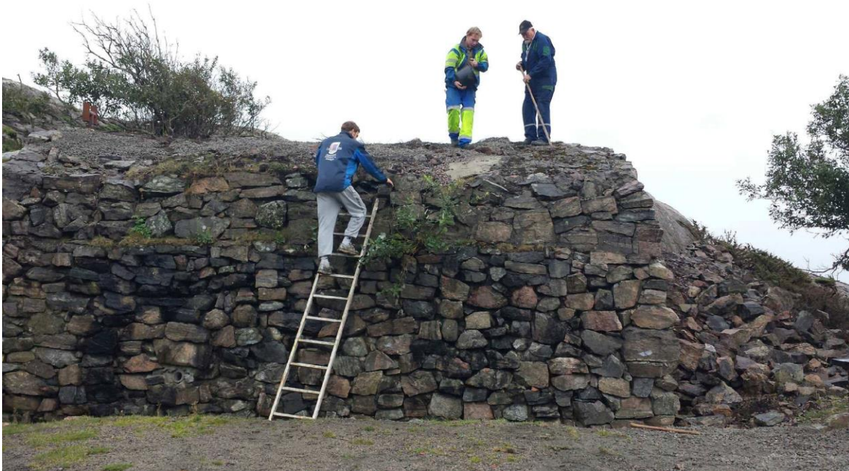
Under reparasjonsarbeider og utlegging av membran på taket av lagerbunker. (Inventarnummer 64)
