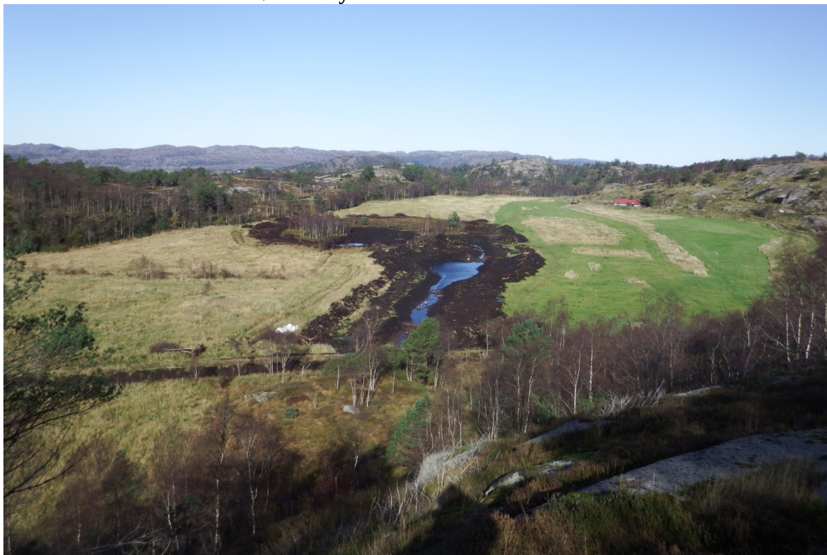
Bilde 1 – Oversikt over arbeidet sentralt i Mønstremyr.
