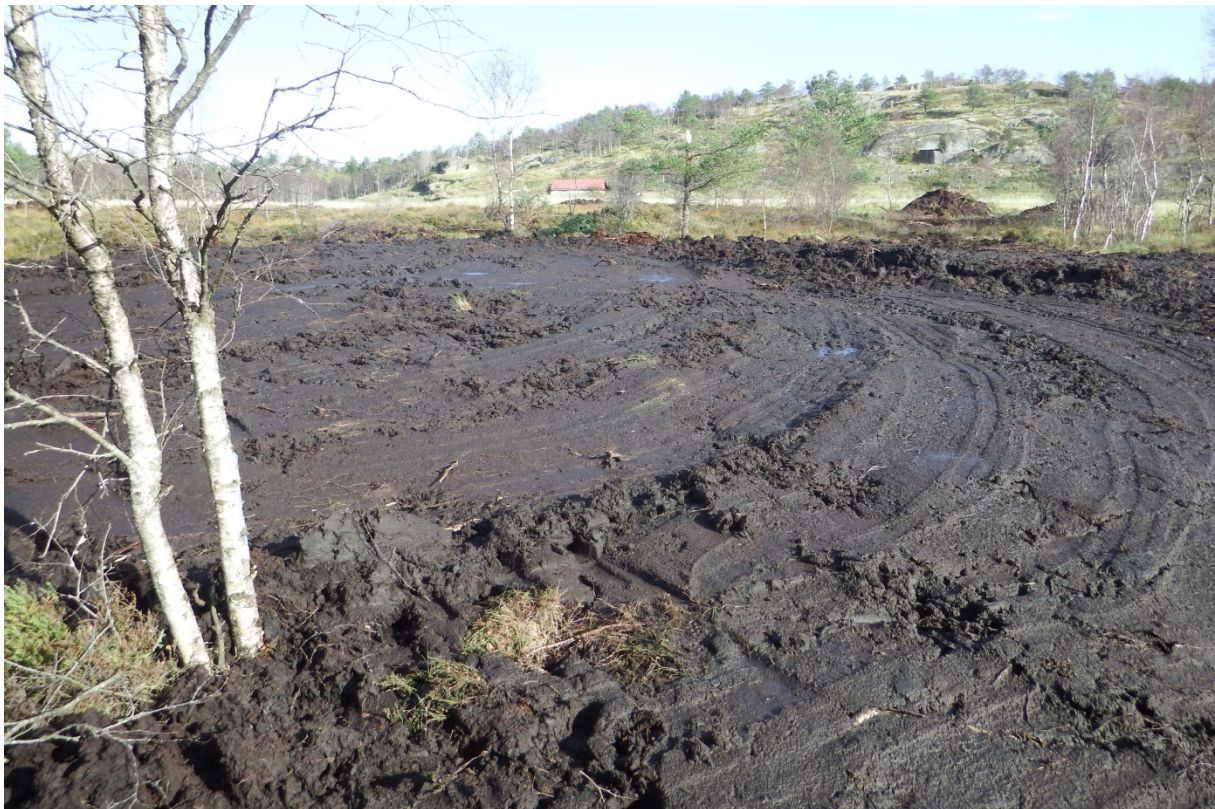
Bilde 6 – Oppgravde masser planeres ut oppå naturlig vegetasjon på udyrket areal.
