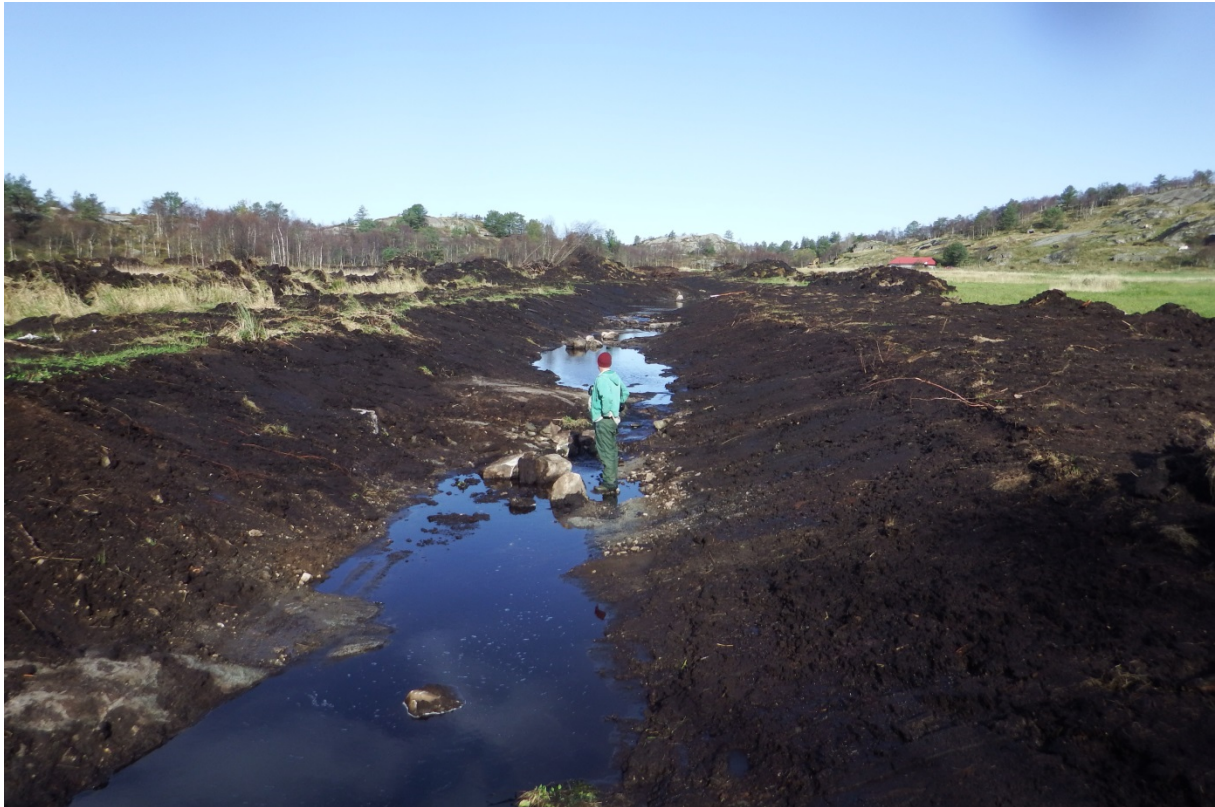
Bilde 3 – Ny kanal fra hovedkanalen opp til siste rest av original torvmyr. Som en kan se er kanalen på flere steder er gravd helt ned til grunnfjellet.
