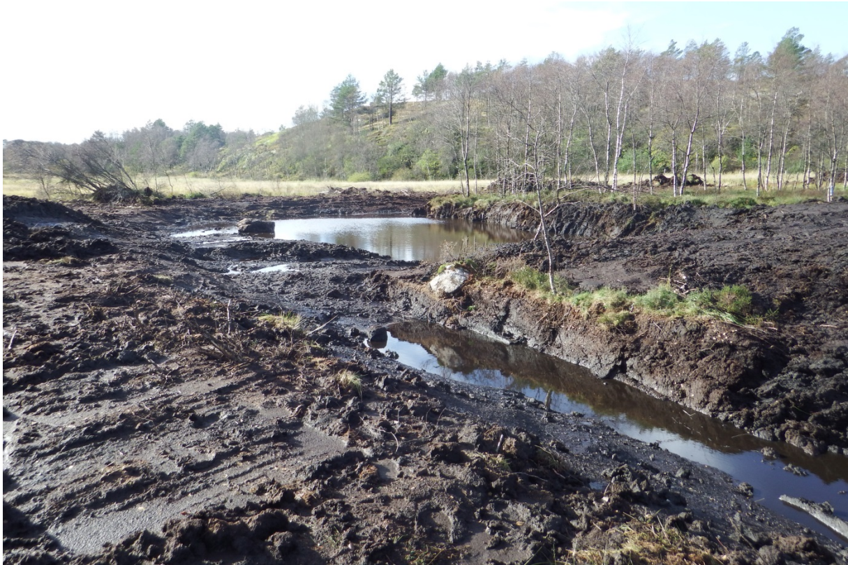
Bilde 7 – Dam på sørsiden av sentral udyrket torvmyr, i forkant utløpskanal som vil holde vannstanden nede.
