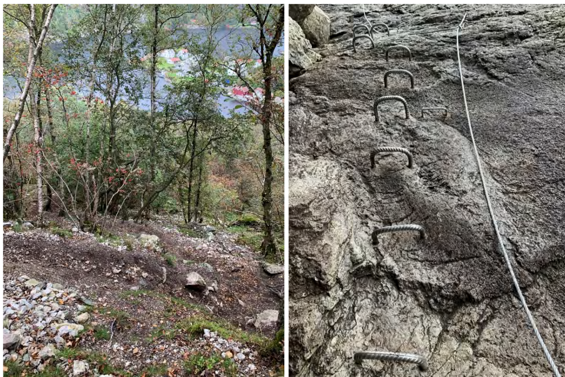
Figur 4 Sti fra Roligheten mot Brufjell går i bratt terreng på ustabil substrat (til venstre). Nedstigning til Brufjellhålene går på Via ferrata med jernsteg boltet i fjellet og med stålwire som sikring (til høyre). Foto: Rambøll.
