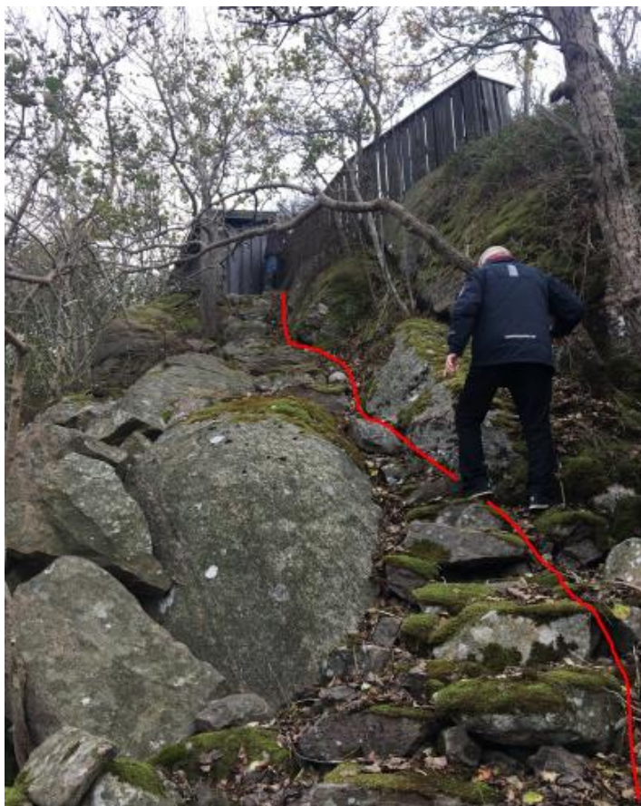
Ledning legges på høyre side av trappe dekket med jord og stein.
