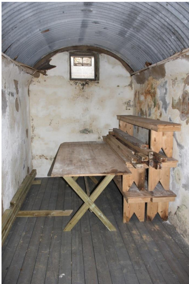
På innsiden av «Østre dekningsbunker» (inv.nr. 92)
