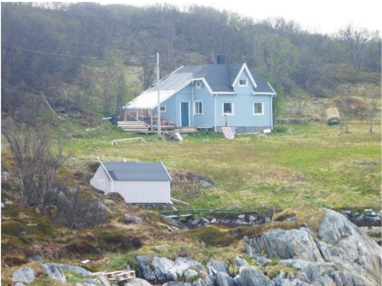
Huset og sjøbua, ferdig restaurert. Bilde fra 2015. (Foto: Jon Pedersen)
