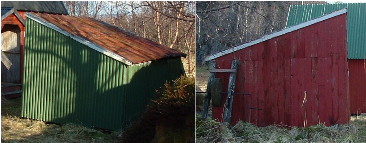
Bilde 3 og 4: bilder av det originale bygget fra 2003, foto Karlsøy kommune
