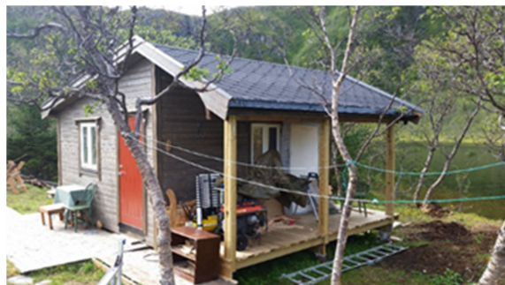
Ny hytte på samme fundament
