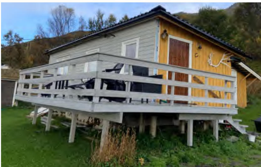
Ny veranda (østsiden)
