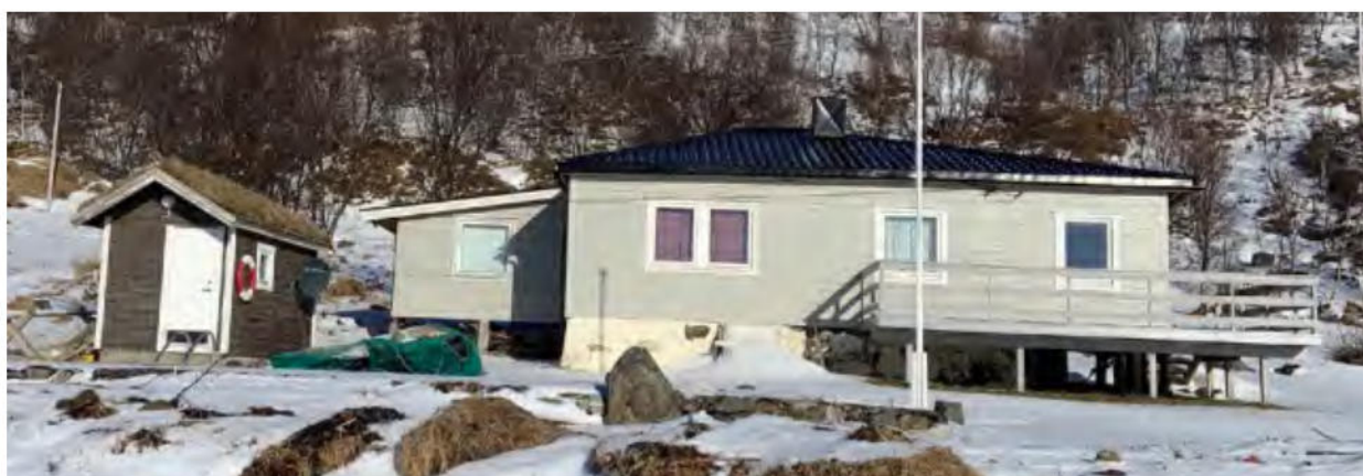
Hovedhus (badstue og veranda) fra sjøsiden etter renovering.
