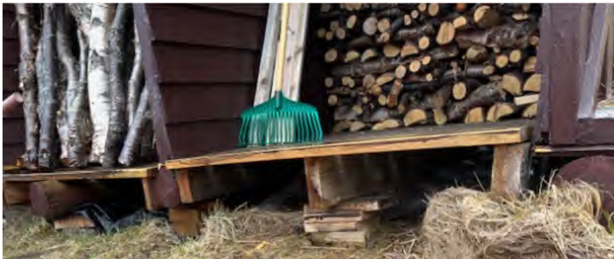
Bilde 2-5: Bilder av vedboden på eiendom 26/6
