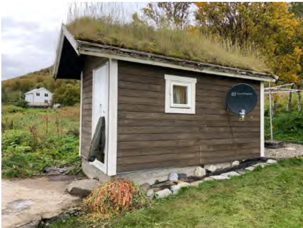
Etter Vedlikehold (se Vedlegg 1 for samme vinkel før)
