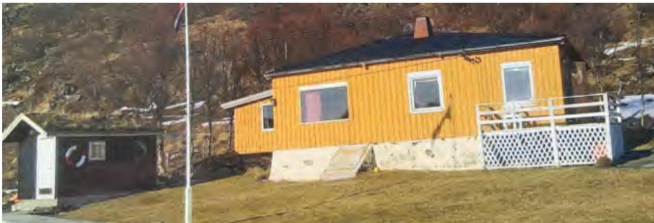
Gammel veranda (sjøsiden) og badstue før renovasjon og vedlikehold
