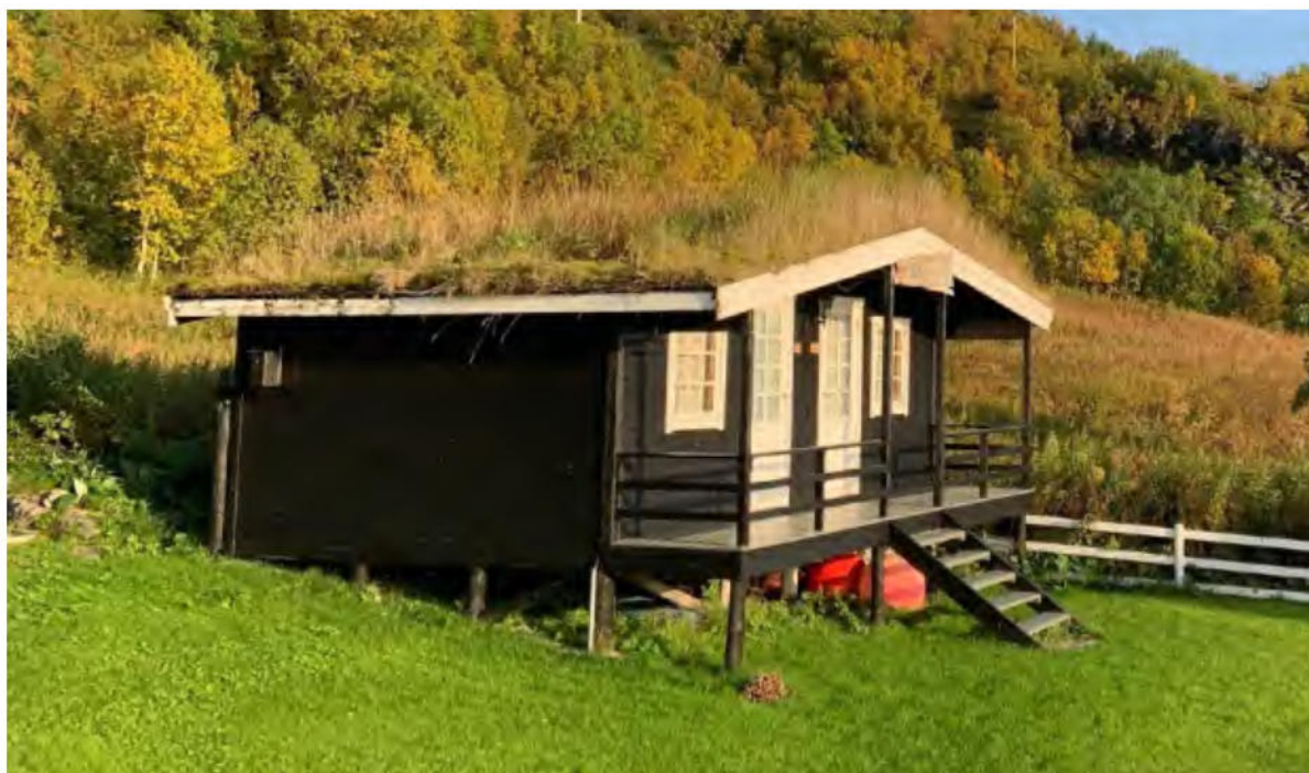
Før skifting av vinduer og dører.
