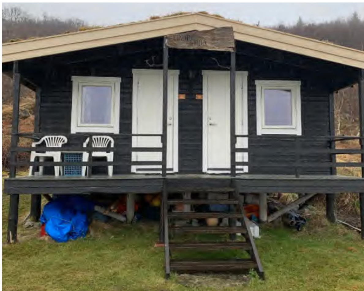
Etter skifting av vinduer og dører.
