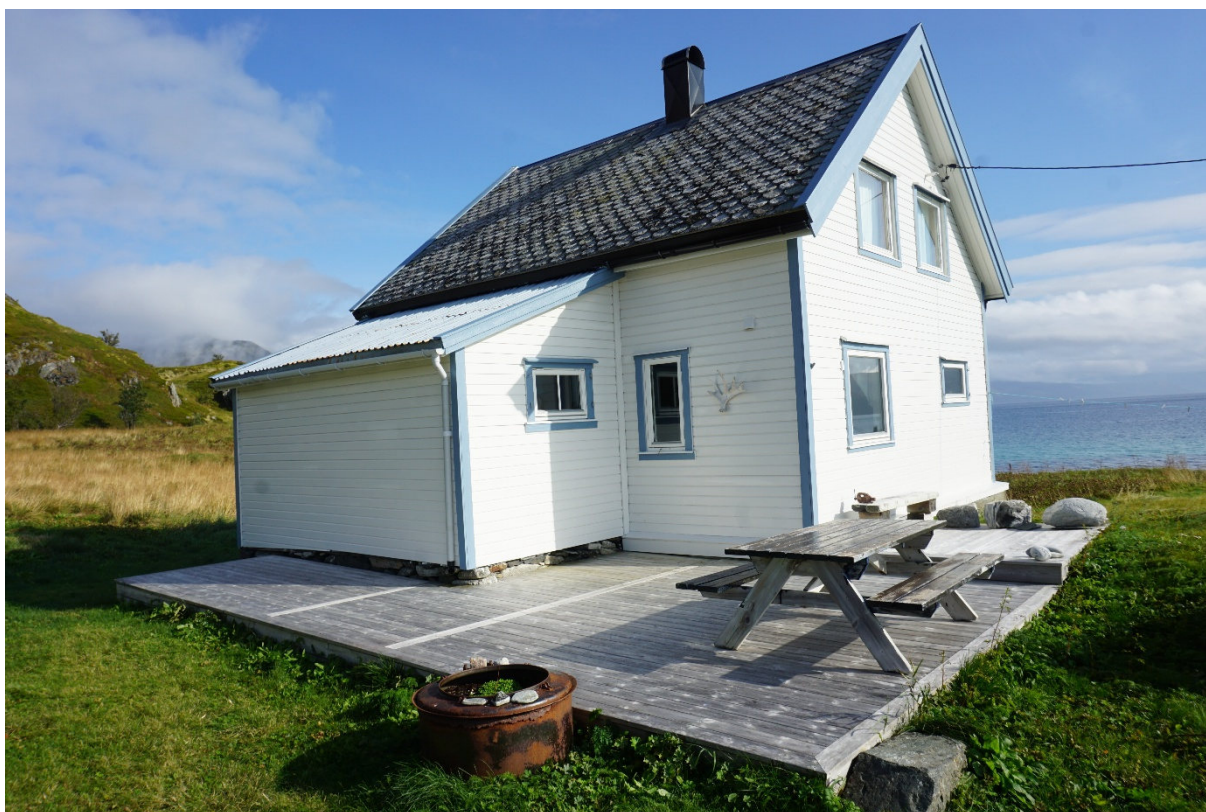
Bilde 9: bilde av våningshus med platting.
