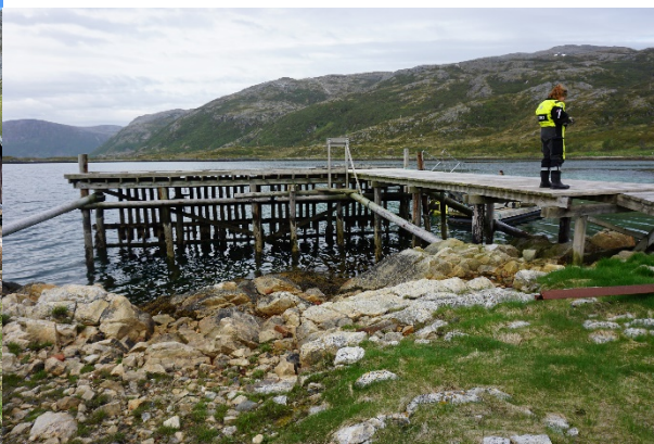
Bilde 11 Befaring foto Stine E. A. Nøding
