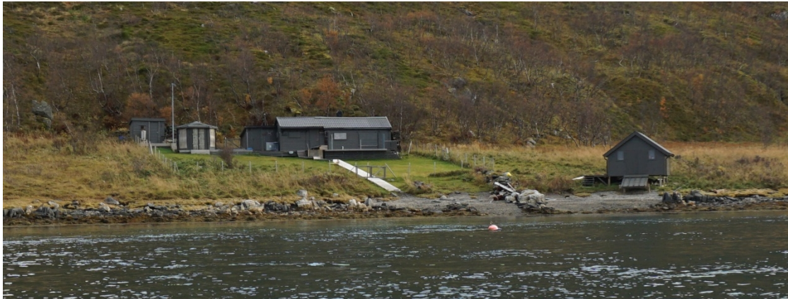
Bilder av bygg på eiendommen fra befaringen i oktober 2020.
