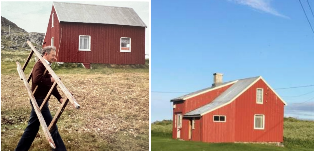
Bilder av huset etter tilbygget ble satt opp, kvisten ble tatt vekk og vinduene ble byttet.
