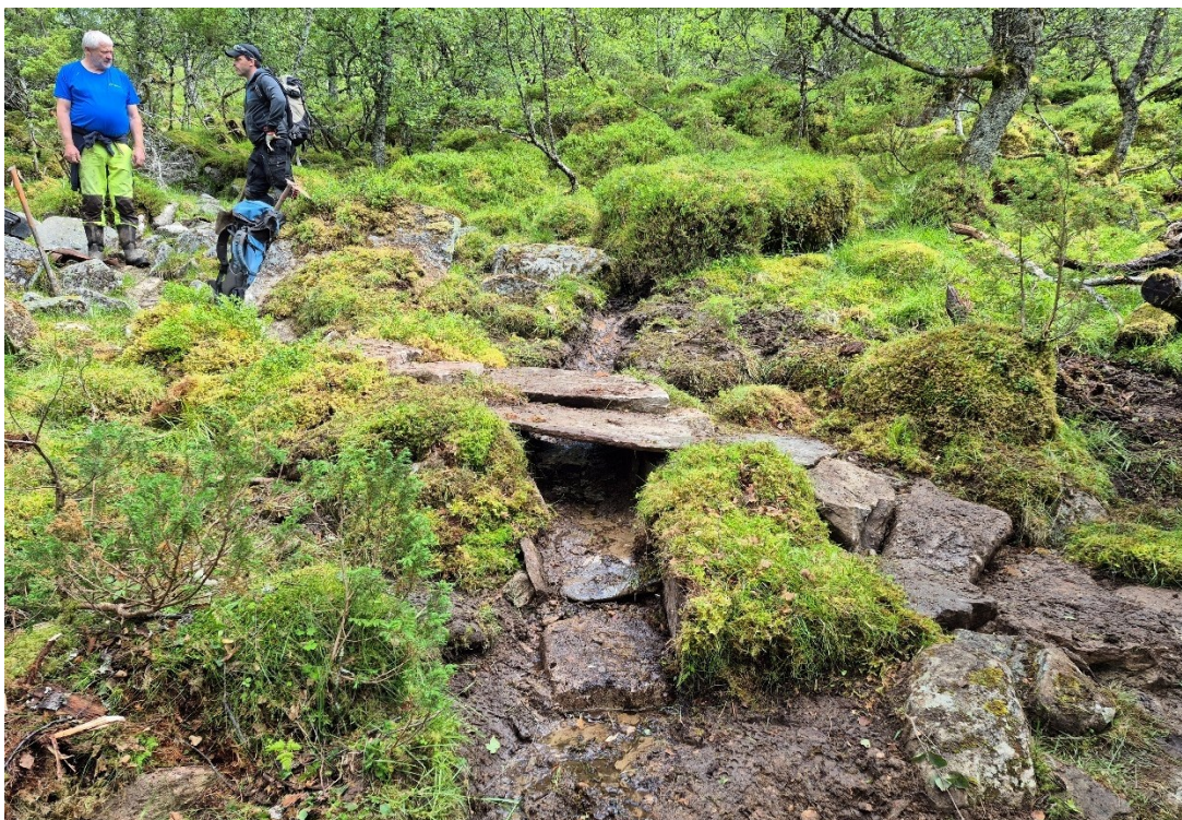
Bilete 4. Manuell utbetring av drifteveg i Traudalen. Vassrenne og steinklopp. Egil Ravnstad frå Bygdeservice og Rune Holen frå SNO. Foto: Alf Erik Røyrvik
