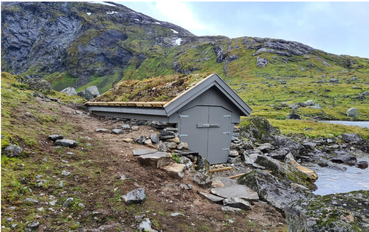
Bilete 4. Ferdig bygd naust ved Kupevatnet i Jølster. Foto: Inge Erikstad
