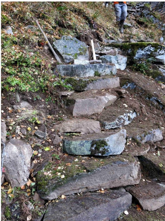
Bilete 10. Steintrappene opp mot Ryssdalshornet under bygging Foto: Alf Erik Røyrvik
