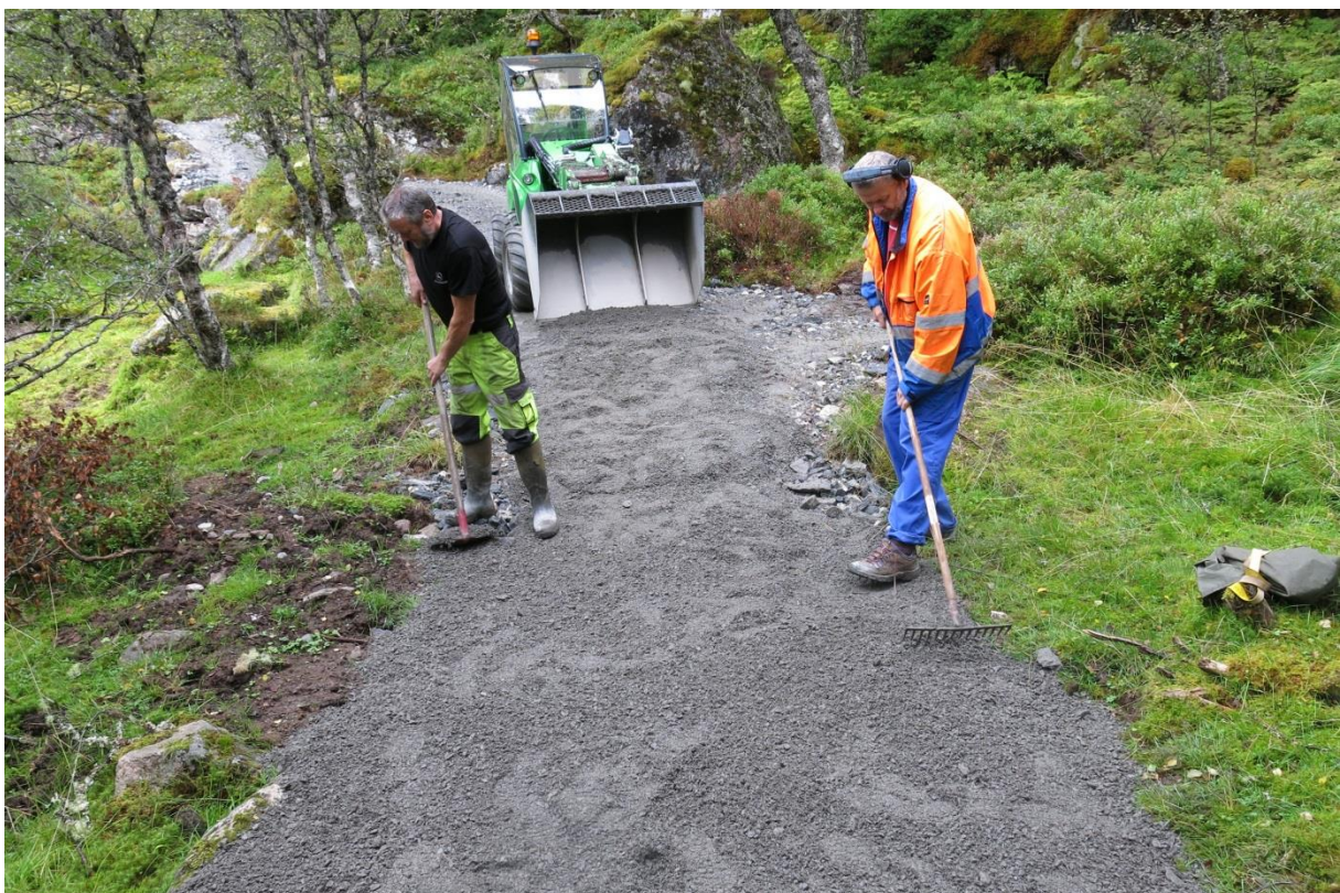
Bilete 6. Ole Gimmestad og Egil Ravnestad gjer siste finpuss på topplaget på buføringsvegen.
