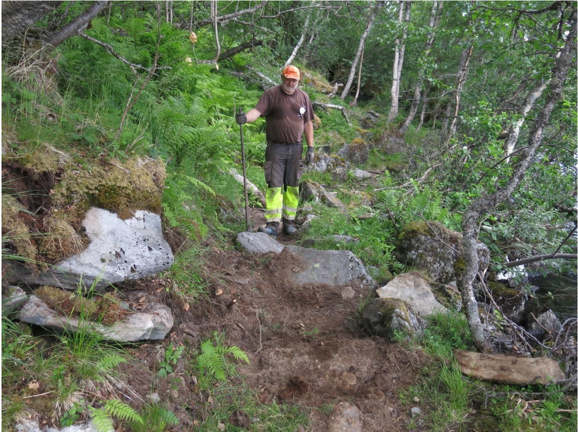
Bilete 5. Tradisjonelt stiarbeid med handreiskap og handemakt gjev resultat
