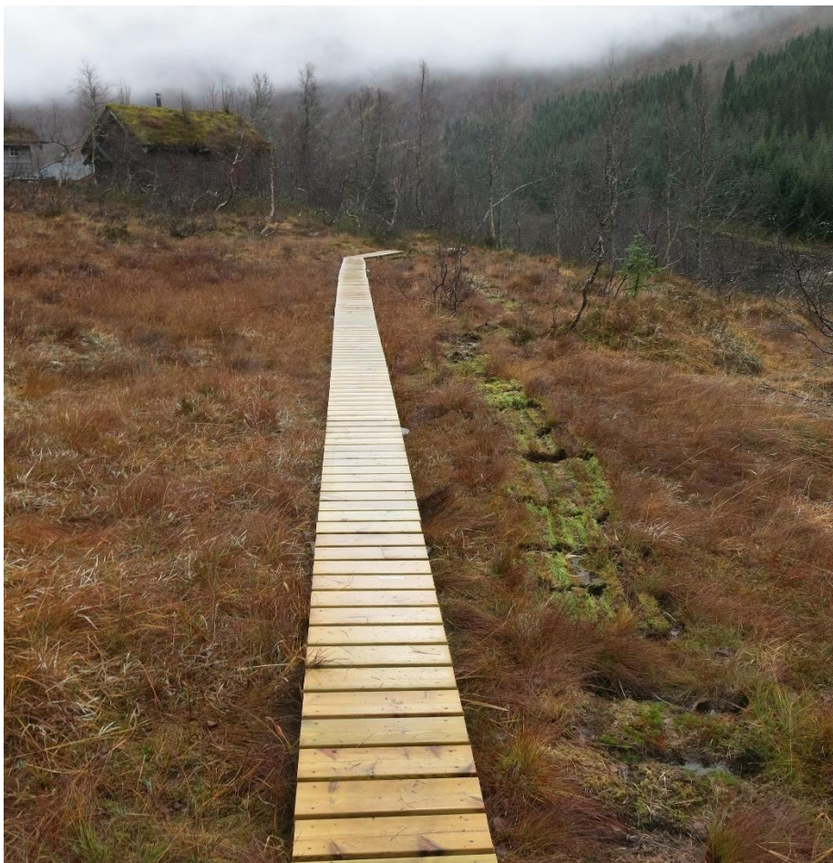
Bilete 6. Klopplegging i Botnen, Angedalen. Ved sidan av ser vi spor etter dei gamle små flakane som var lagt ned langs stien. Den nye klopplegginga er samanhengande og meir robust.
