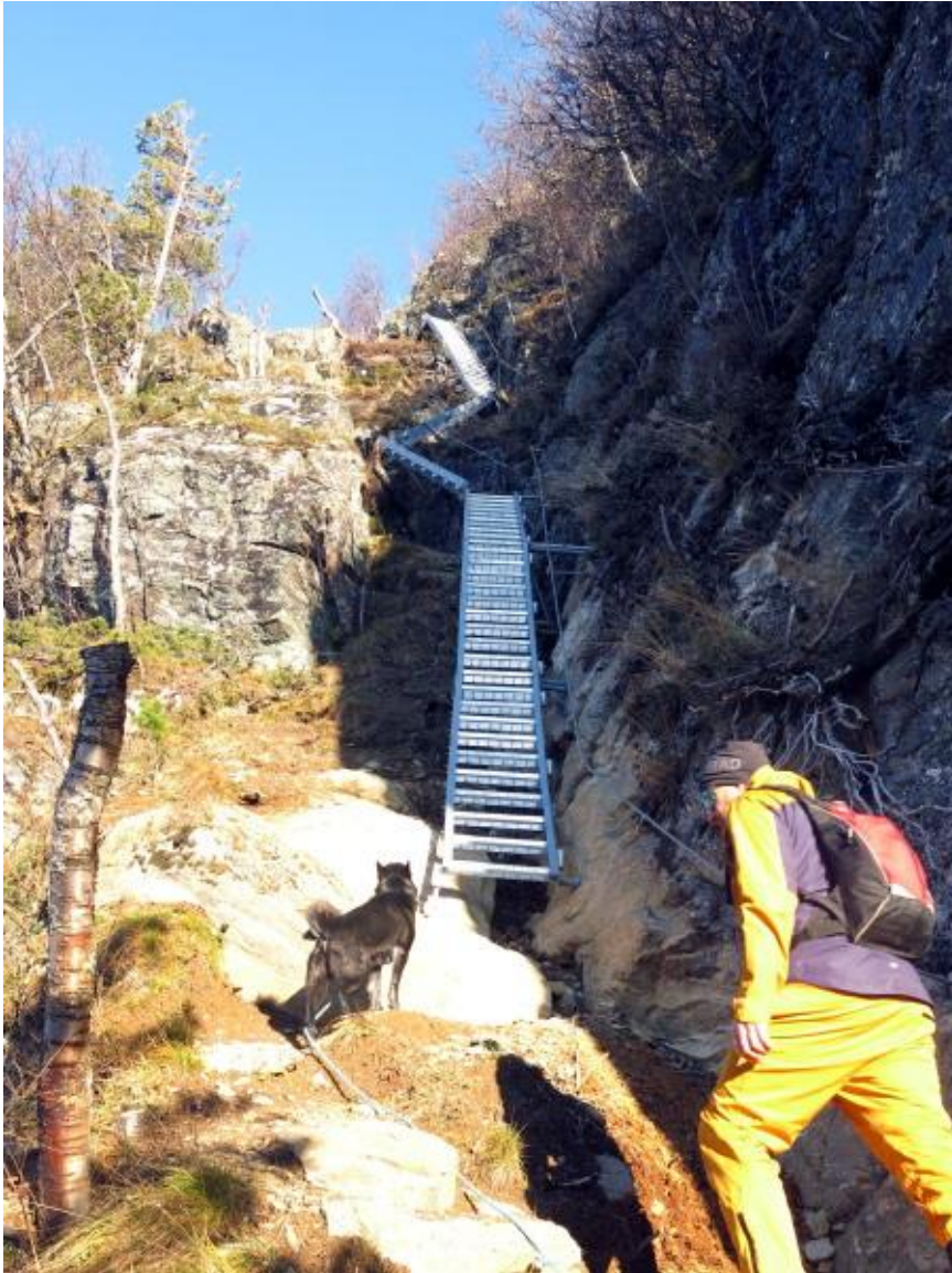
Bilete 8. Trappene i Geitabykset vart ferdigstilt hausten 2019. Trappene gjer det både lettare og tryggare å passere det bratte partiet, kor det og var tydeleg slitasje på stien.
