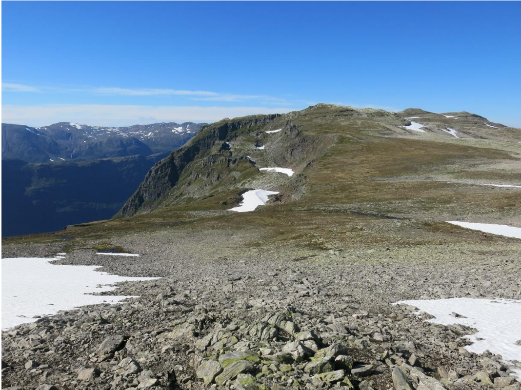
Bilete 6. Osmundnesskaret. Terrenget til venstre i biltetet vert overvaka som ustabil fjell av NVE. Vi kan sjå at terrenget er fullt av sprekker og over lang tid har sige ut.
