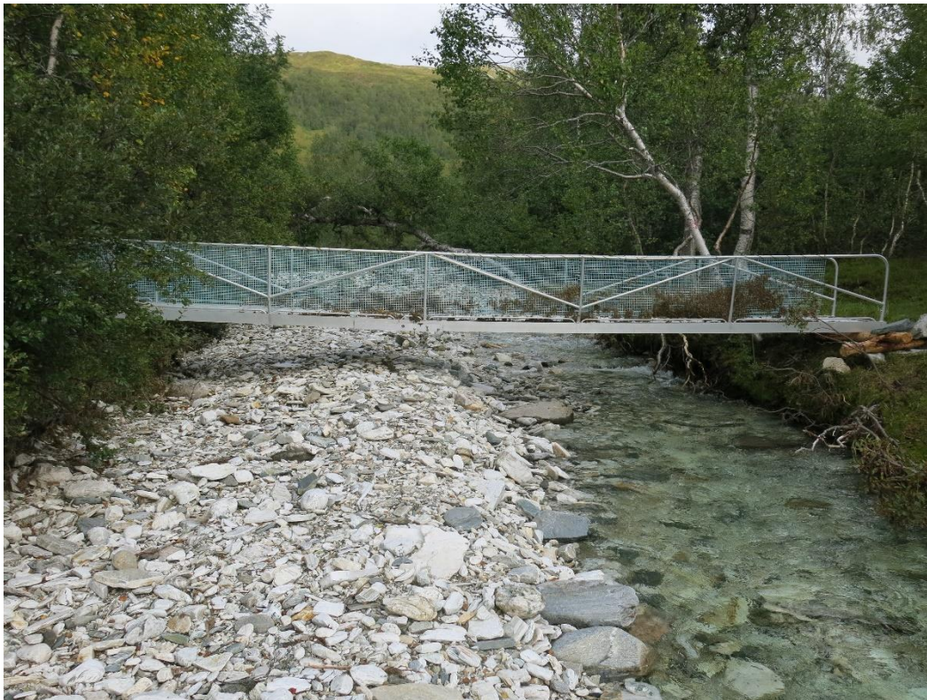
Bilete 11. Brua over elva i Byrkjeneset. Endra elveløp etter flaum i juli 2017. Foto: Alf Erik Røyrvik
