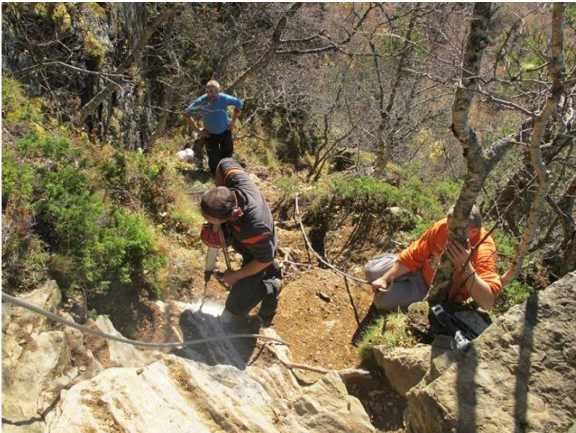
Bilete 8: Sikringsarbeid på stien til Ryssdalshorn. Ole Gimmestad, Kurt Fosheim og Egil Ravnestad frå Bygdeservice AS festar wire til berget i det bratte partiet «Geitabykset». Foto: Rune Holen
