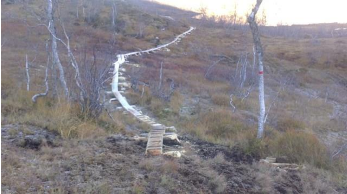
Bilete 9: Klopplegging i på stien mellom Vonavatnet og Nesstølen. Arbeidet utført av Narve Fimland og Kåre Ullaland frå Arnt Laukeland AS. Foto: Kåre Ullaland/Narve Fimland
