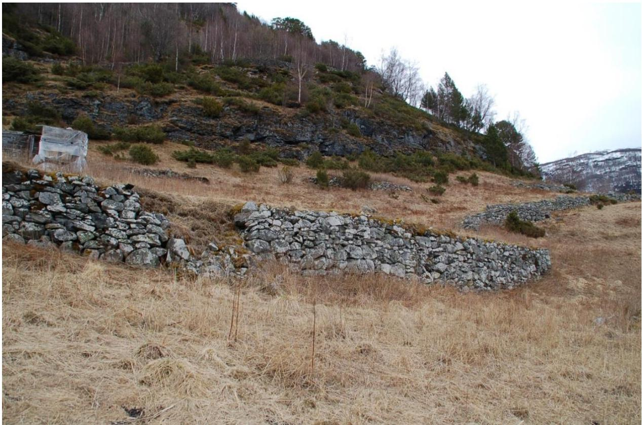
Figur 14 Ein av dei største skadane på stormuren aust for tunet.
