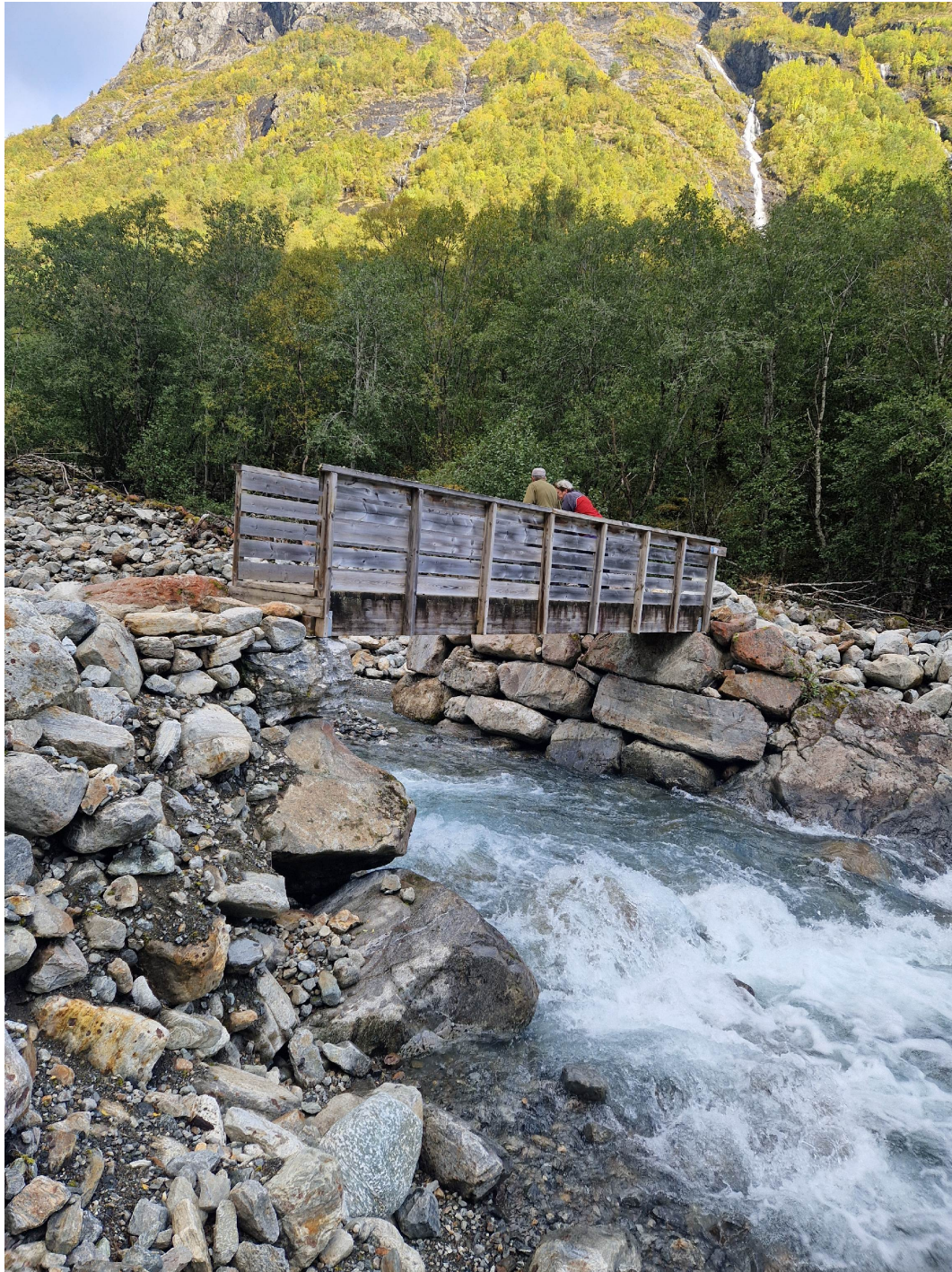
Figur 4. Bilete frå synfaring september 2026. Viser det partiet av brukaret som er mest utgåvd, nedstrøms brua.
